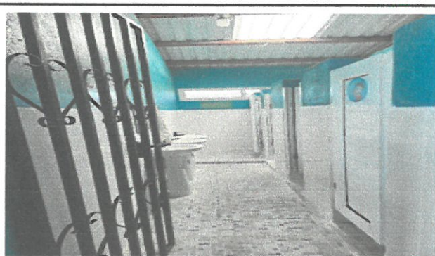
Finalización de sustitución de lavamanos
