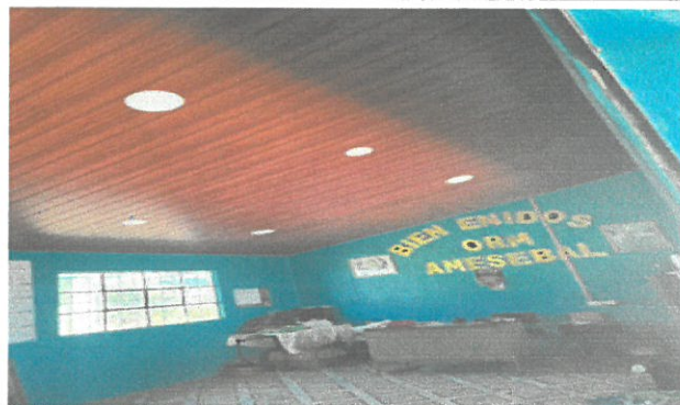
Culminación de Cielo Falso para dirección
