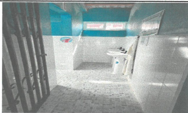
Finalización de cambio de ventana por mal estado
