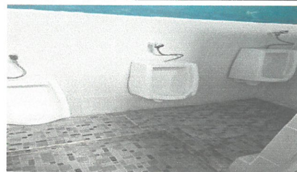
Finalización de cambio de azulejos por mingitorio
