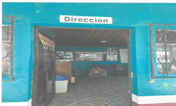
Culminación de Cielo falso para dirección
