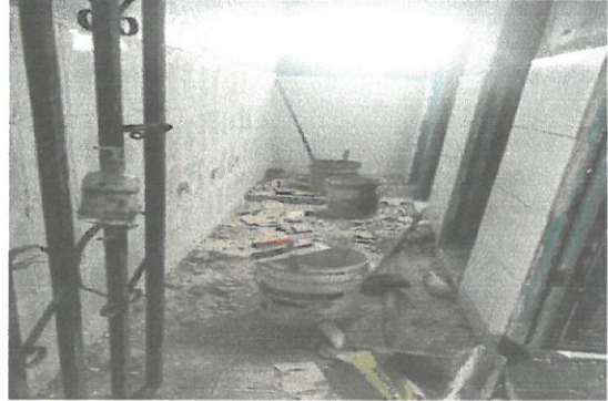
Colocación de tubería para lavamanos
