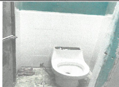
Cambio de piso y tasas sanitarias por estar en mal estado
