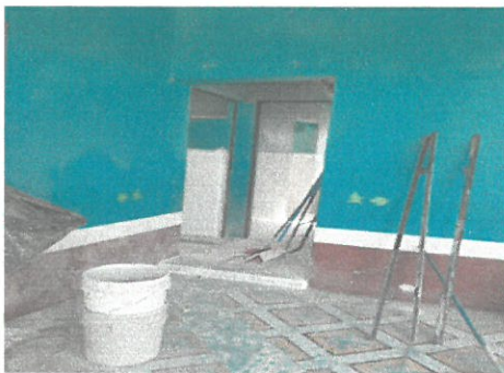
Cambio de azulejos
