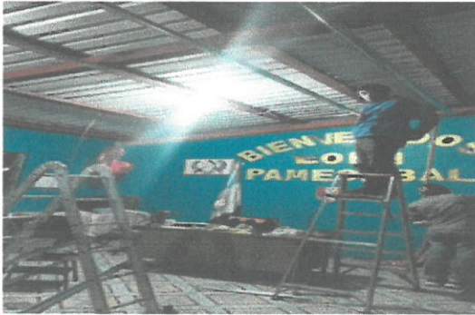
Colocación de cielo falso para dirección
