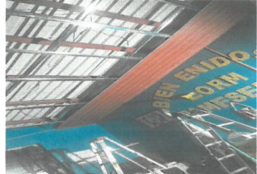
Colocación de cielo falso para dirección
