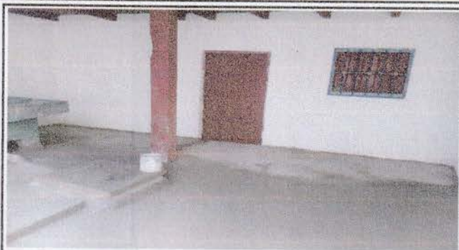
Foto 8: Repello terminado parte frontal de la cocina
