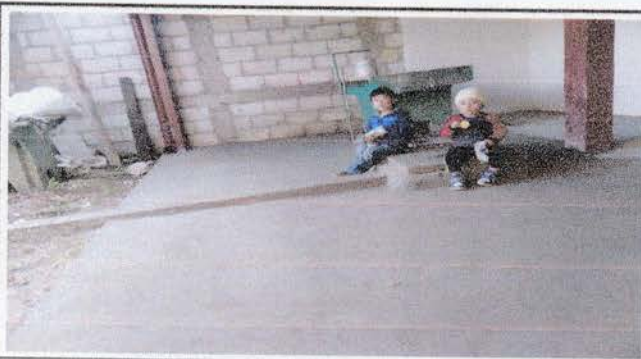
Foto 4: Reubicación de tubo de caída de agua.
