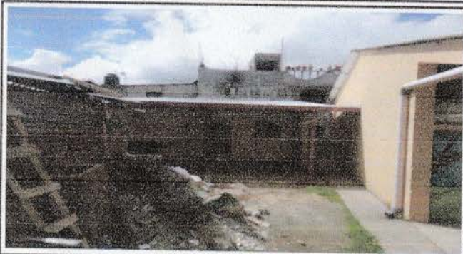
Foto 1: Techo de la cocina terminado.
