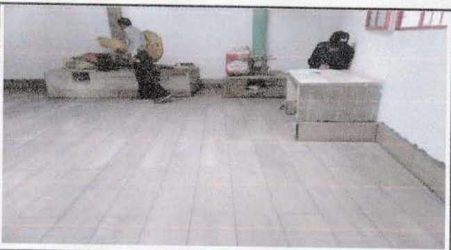
Foto 3: Piso terminado dentro de la cocina
