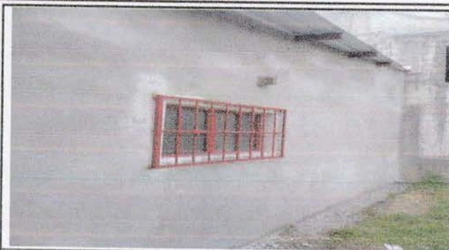
Foto 2: Repello finalizado del exterior de la cocina.
