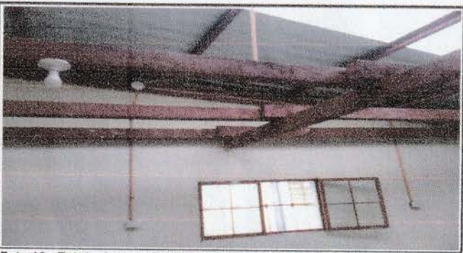
Foto 12: Entubado de cables y nuevo sistema electrico.
