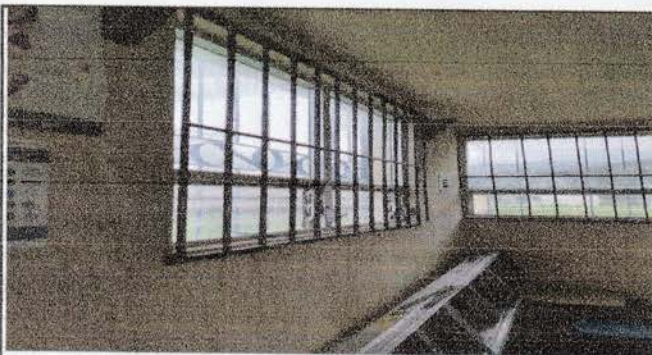
Foto 9: Balcones colocados en el interior.
