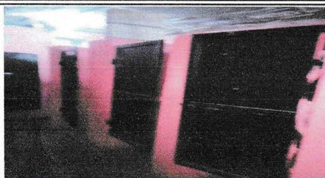
Foto 7: La puerta es llevada para su reparación.
