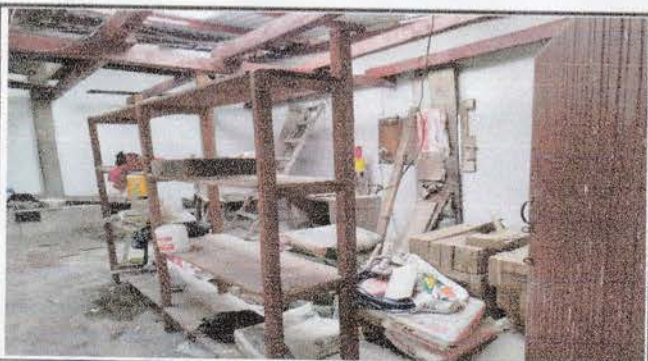
Foto 3: Proceso de adecuación de espacio para la colocación de piso dentro de la cocina
