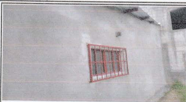
Foto 2: Inicio de repello de la parte exterior de la cocina.
