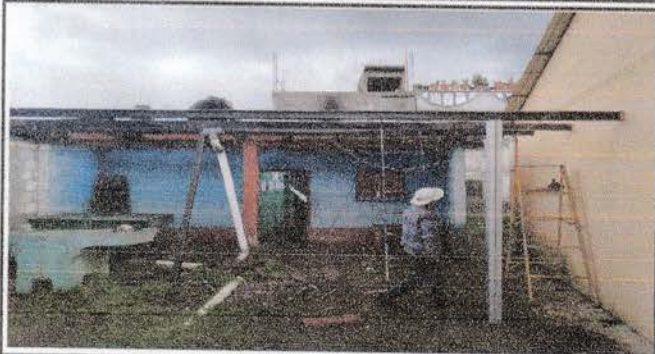
Foto 1: Proceso de instalación de vigas en la cocina.
