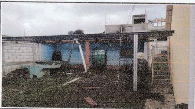
Foto 4: Retiro de Canal de caída de agua pluvial.
