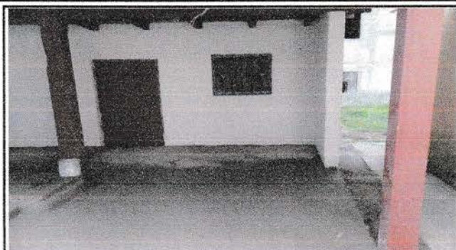
Foto 8: Culminación de una primera parte de repello de la cocina.
