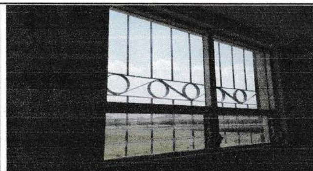
Foto 9: Se estan fabricando los balcones de refuerzo interno
