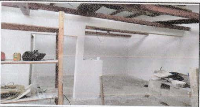
Foto 5: Remodelación del interior de la cocina quitando una pared.
