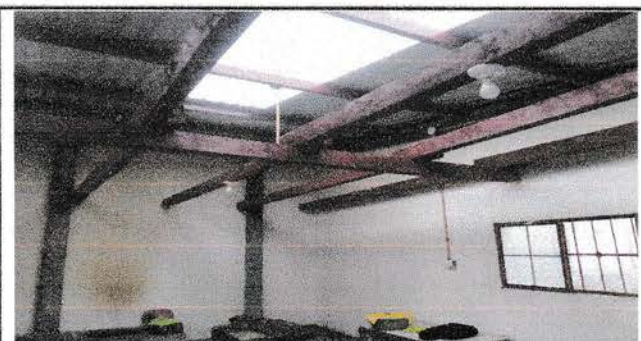
Foto 11: Explicación de los requerimientos dela nueva instalación electrica.
