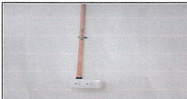
Foto 12: Proceso de instalación de caída de agua.
