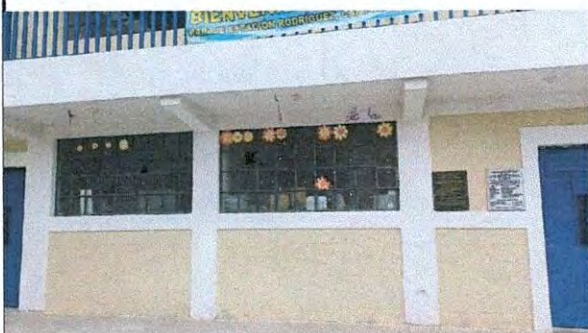
Foto 3: Reparacion de vidrios rotos y colocación de balcones para las ventanas de la parte del primer nivel.
