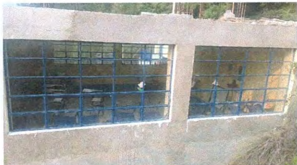
Foto7: colocacion de balcones en ventanas que dan hacia la montaña.
