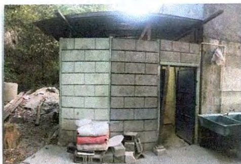
Foto 5: Cambio nde puerta de la cocina.
