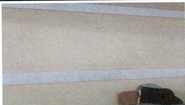
Foto 11: repello de paredes de Salon
