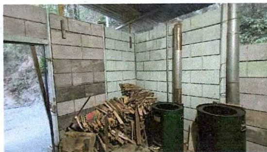
Foto 4: Repello de cocina
