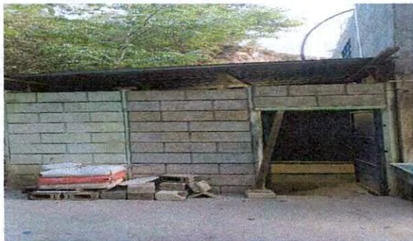
Foto1: colocación de pizo en cocina. Fubndicion de solera para asegurar paredes, ya que son prefabricadas.
