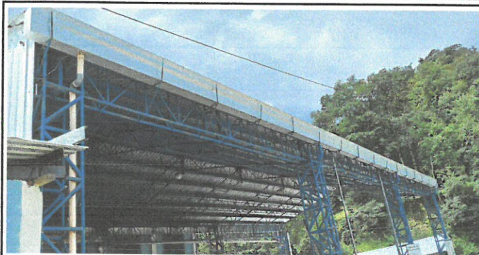
Foto1: Region 1.1 Sutiución sistema de canales pluviales
