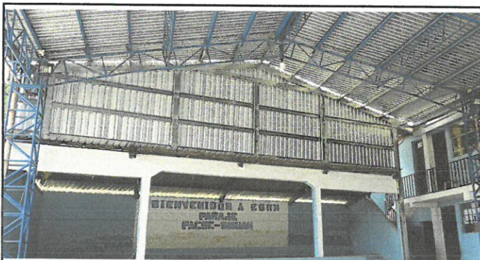
Foto 3: Region 2.2 Ampliacion techo del patio y area de gradas
