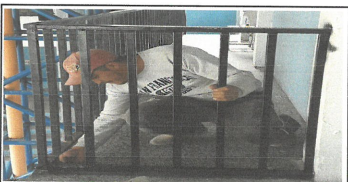
Foto 5: Modulo 3.1 complemento de baranda segundo nivel.
