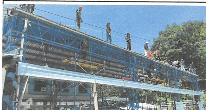
Foto1: Region 1.1 Sutiución sistema de canales pluviales
