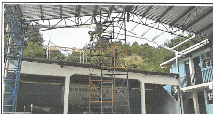
Foto 3: Region 2.2 Ampliacion techo del patio y area de gradas
