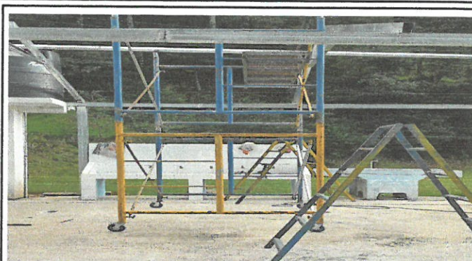
Foto 2: Region 2.1 Sustitucion de estructuta y techo area del lavamanos
