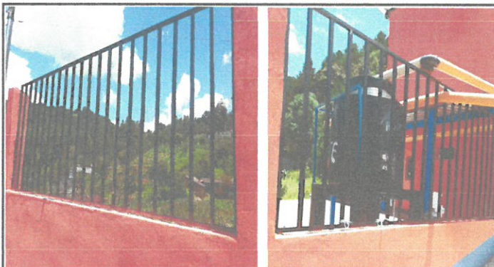
sustitución de barandas de metal suministro e instalación
