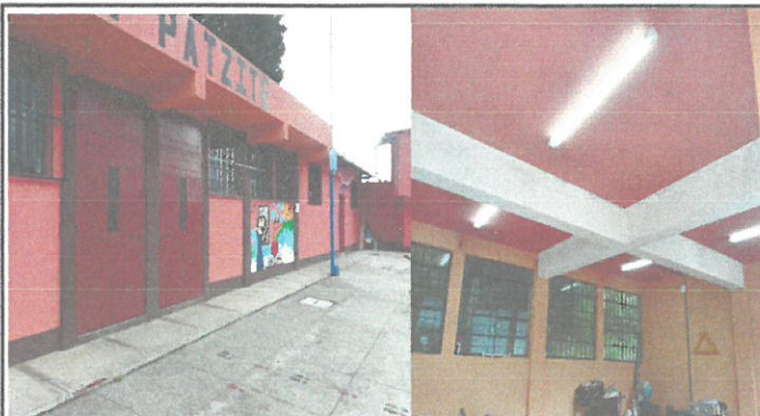
pintura de muros y paredes interior y exterior
