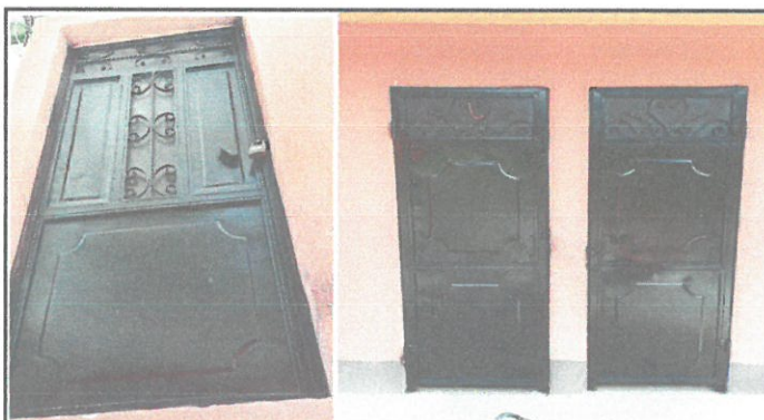
pintado y reparación de puertas
