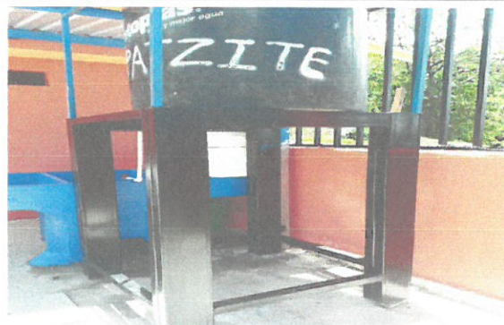
instalación de base para depósito de agua
