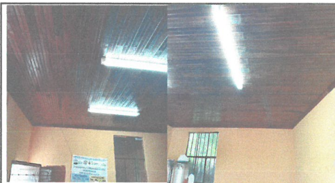
instalación de cielorraso dentro de la cocina
