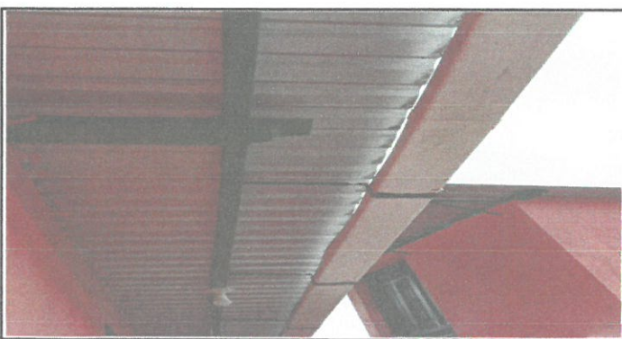
sustitución de canales a canales de alto caudal con ganchos sostenedores
