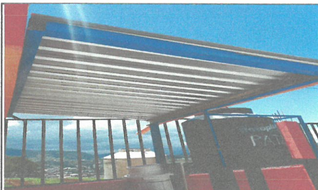
sustitución de cubierta de lámina y bajadas de agua
