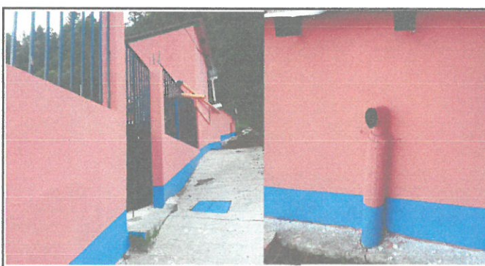
reparación de paredes repello y cernido
