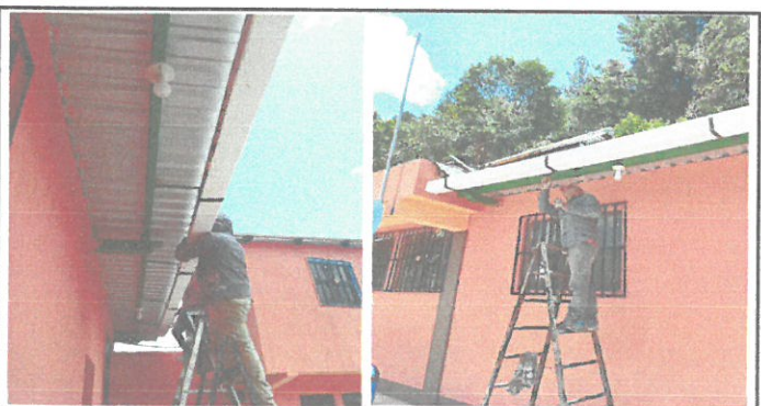
sustitución de canales a canales de alto caudal con ganchos sostenedores
