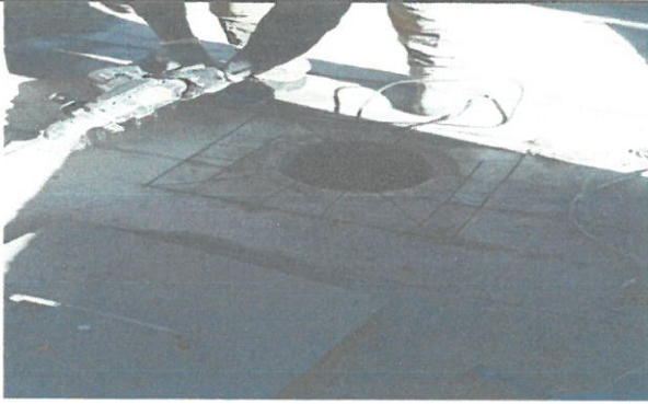
reparación de base y tapadera de candela de drenaje.
