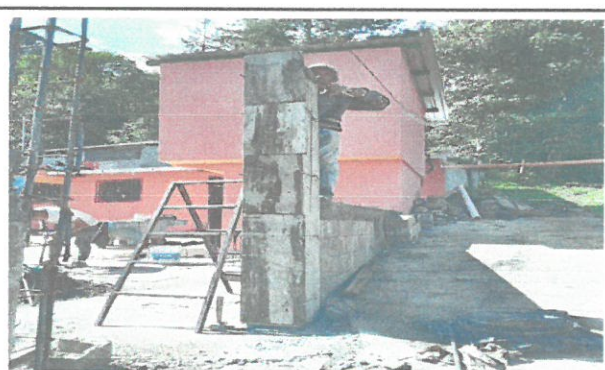
culminación de columnas para colocación de puerta principal (entrada)
