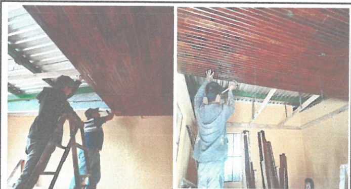
instalación de cielorraso dentro de la cocina
