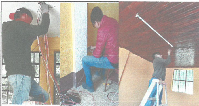
sustitución de toda la red de energía eléctrica, cables de diferentes calibres tomacorrientes, interruptores entubados de línea general placas, lamparas, tiembres ....
