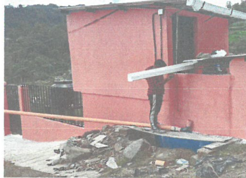
sustitución de cubierta de lámina y bajadas de agua
