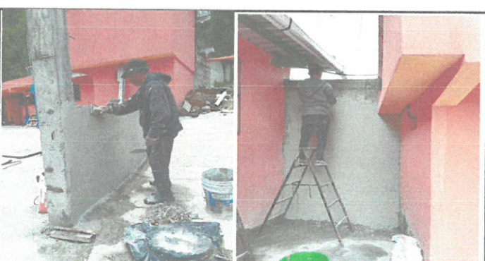
reparación de paredes repello y cernido
