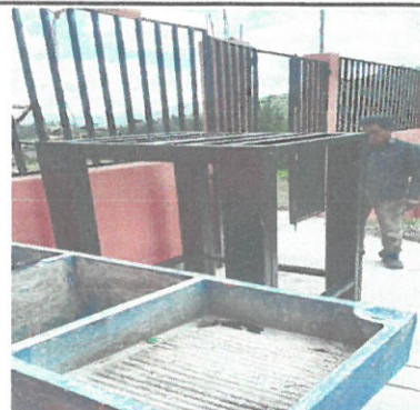
instalación de base para depósito de agua
