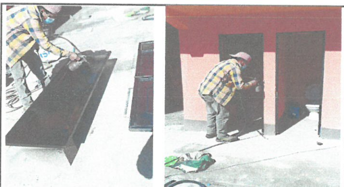
pintado y reparación de puertas
