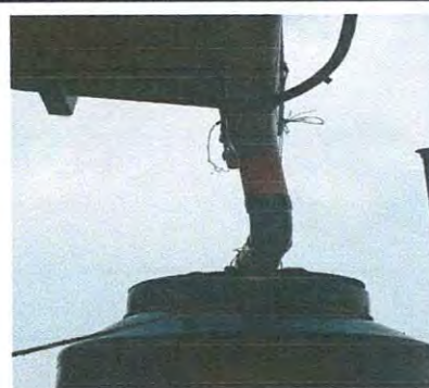
sustitución de cubierta de lámina y bajadas de agua
