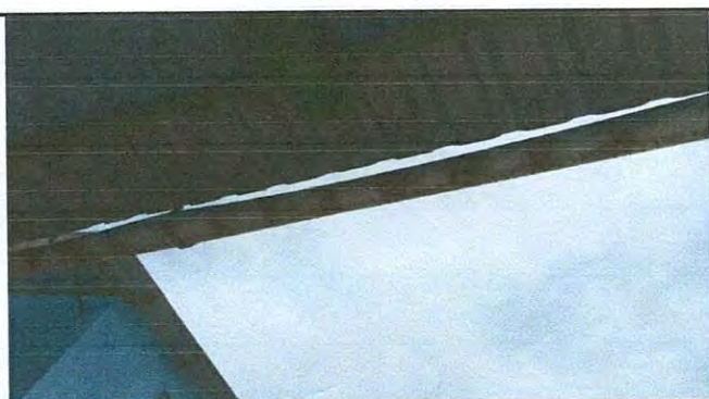
sustitución de canales a canales de alto caudal con ganchos sostenedores
