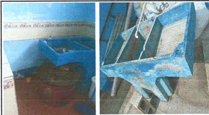
instalación de pila a la red de drenaje dentro de la cocina y fuera de la cocina
