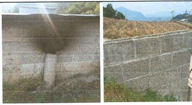
reparación de paredes repello y cernido
