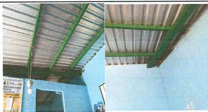
instalación de cielorraso dentro de la cocina
