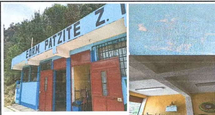
pintura de muros y paredes interior y exterior
