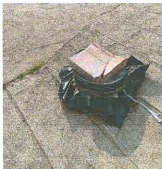
reparación de base y tapadera de candela de drenaje.
