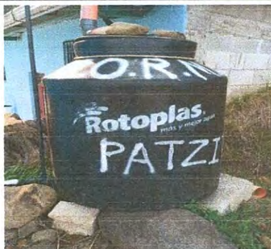
instalación de base para depósito de agua
