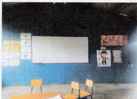
Foto 5: paredes interiores pintadas
