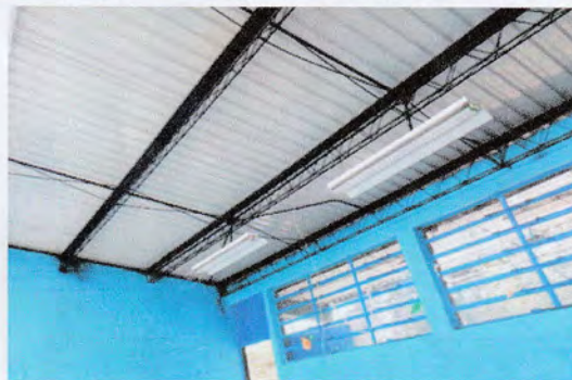
Foto 2: Cambio de estructura de metal
