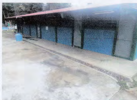
Foto 4: EORM paredes externas y puertas pintadas
