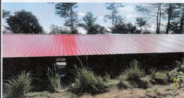
Foto 1: cambio de techo
