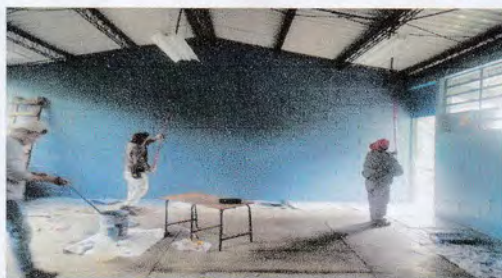
Foto 5: pintando la parte interior del centro educativo
