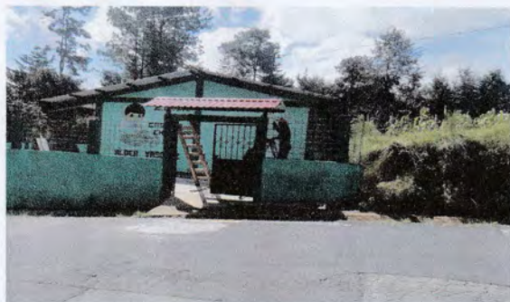
Foto 3: Colocación estructura de metal y lamina entrada de la EORM
