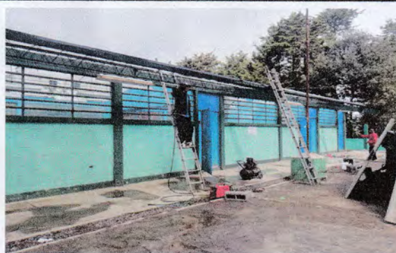
Foto 2: Cambio de estructura de metal
