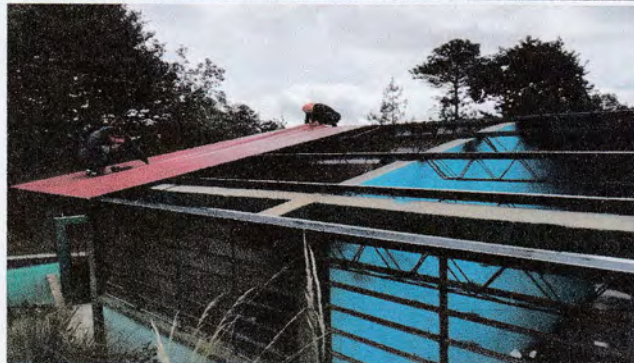
Foto 1: cambio de techo
