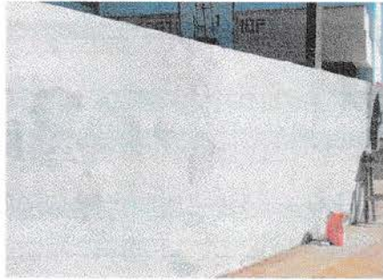
Foto1: Remozamiento de muro
