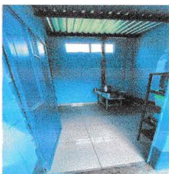
Foto 3: Instalación de piso porcelanato en cocina 2
