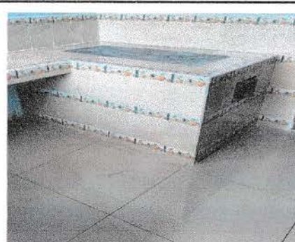
Foto 2: Instalacion de piso porcelanato en cocina 1
