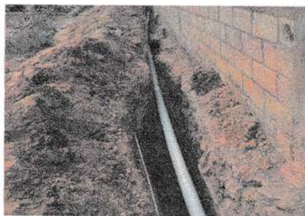
Foto 5: Instalacion de tubo de drenaje
