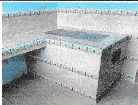
Foto 1: Azulejo instalado en su totalidad en plancha de cocina 1
