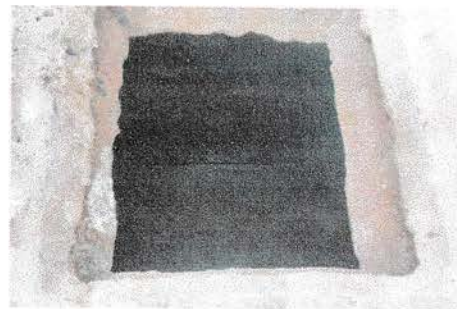
Foto 6: mantenimiento de fosa septica
