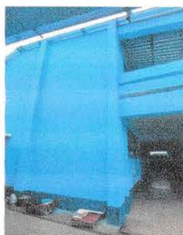
Foto 6: Aplicacion de pintura en el establecimiento educativo
