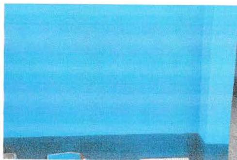
Foto 1: Aplicación de pintura en todos el establecimiento educativo
