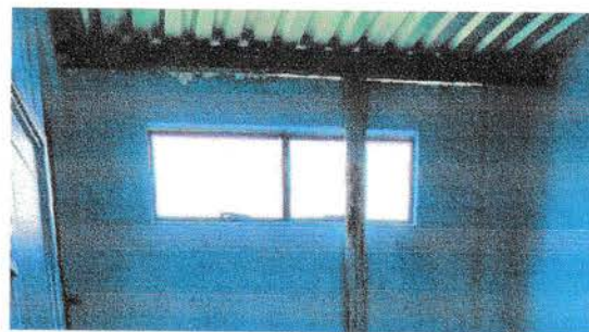
Foto 4: Instalacion de ventana en cocina 2
