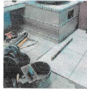
Foto 2: Instalación de piso porcelanato en cocina 1
