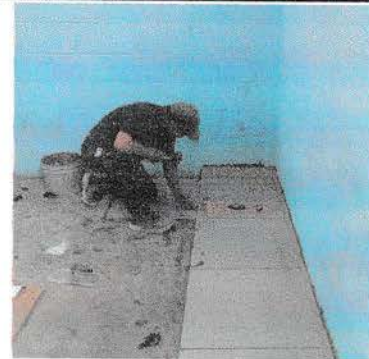
Foto 4: Instalación de piso porcelanato en bodega
