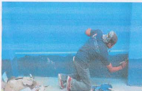
Foto1: Aplicación de pintura en todos el establecimiento educativo
