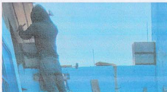
Foto 3: Se agragan dos block en cada extremo y soera final
