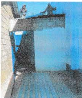
Foto 5: Instalación de estructura metálica y cubierta de lámina troquelada
