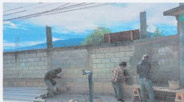
Foto 4: Repello gris en muro de block.
