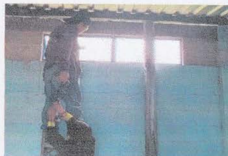
Foto 4: Instalacion de ventana en cocina 2
