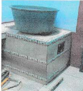
Foto 1: Instalación azulejo a plancha de cocina 1
