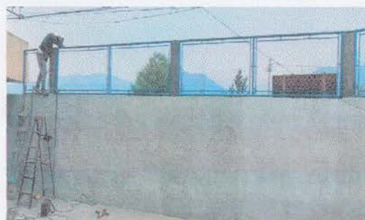
Foto 2: Instalacion de malla en muro de block existente.
