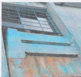
Foto 3: Instalacion de ventana en el segundo nivel
