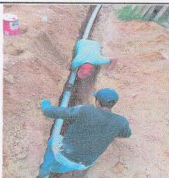
Foto 5: Instalacion de tubo de drenaje
