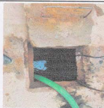
Foto 6: Extraccion de liquidos y desechos solidos en fosa septica
