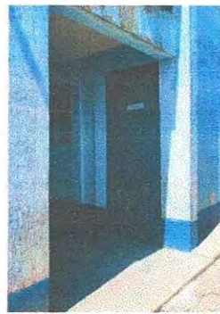
Area para instalacion de puerta corrediza
