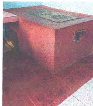
Cocina 1 Area donde se instalara piso porcelanato
