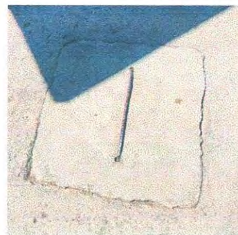
Mantenimiento de fosa septica
