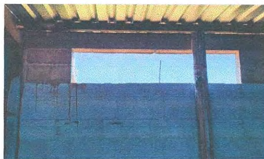
Instalacion de ventana en cocina 2
