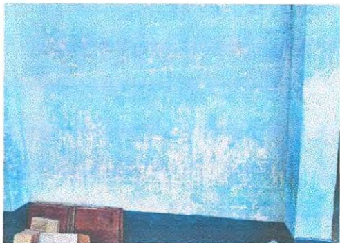
aplicación de pintura
