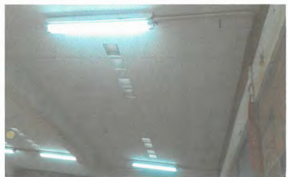
Foto 4: Sustitución de lamparas quemadas por nuevos adquiridos incluyendo suministros materiales y mano de obra.
