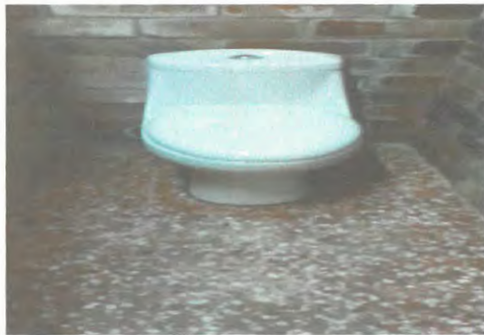
Foto 3: Inosoeo númweo dos nuwco instalado baño de niñas
