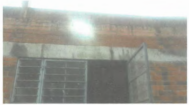
Foto 4: Reflector nuevo instalado entrada al edificio.
