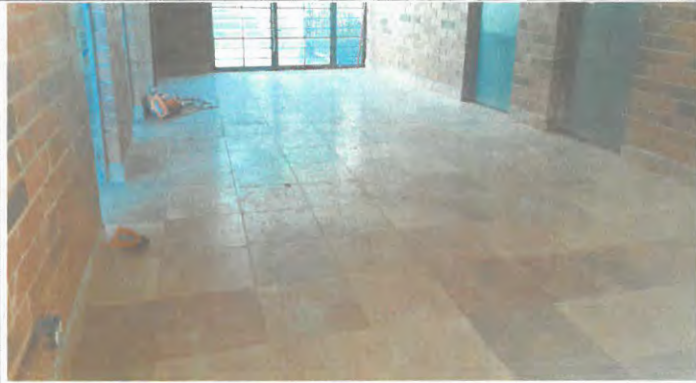
Foto 1: Piso instalado en el pasillo frente la dirección dos aulas y corredor.
