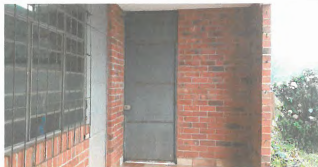
Foto 6: Puerta de emergencia instalada lado este de la escuela, despues de heber cortada.
