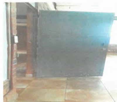
Foto 4: Puerta colocada en el salón despues de haber cortada.
