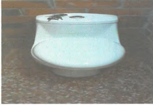
Foto1: Inodoro nuevo instalado en el baño de hombres
