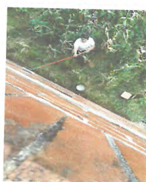
Foto 3: Echándole AGUALOK para impermeabilizar muros de ladrillos interiores y exteriores.
