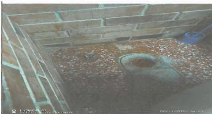
Foto 3: Sustrucción de letrina dos de niñas incluyendo suministros, materiales y mano de obra.
