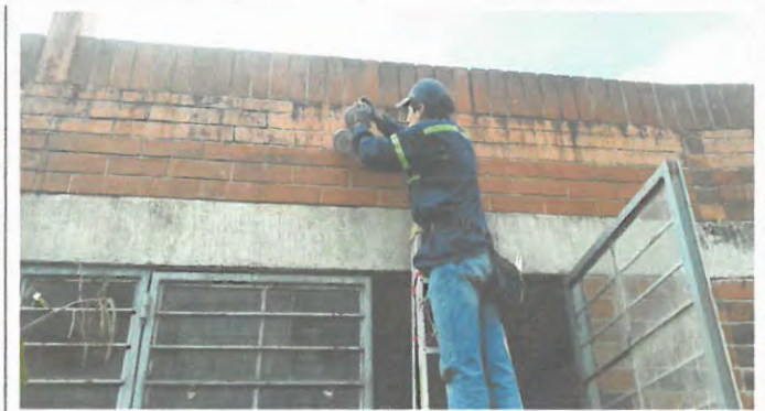
Foto 4: Sustrucción reflectores quemadas por nuevos adquiridos incluyendo suministros materiales y mano de obra.
