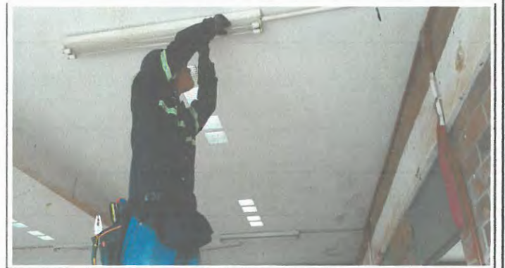
Foto 4: Sustitución de lamparas quemadas por nuevas adquiridos incluyendo suministros materiales y mano de obra.
