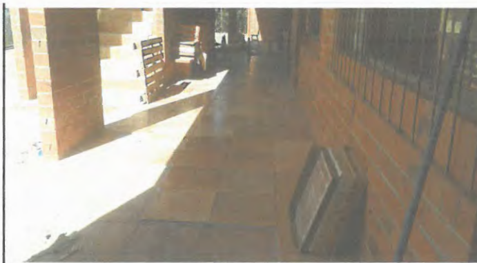
Foto 3: En el corredor del primer nivel se instalará piso, incluyendo suministros, materiales y mano de obra.
