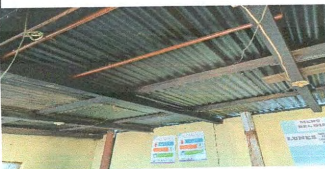
Foto 5: Reparación del sistema eléctrico
