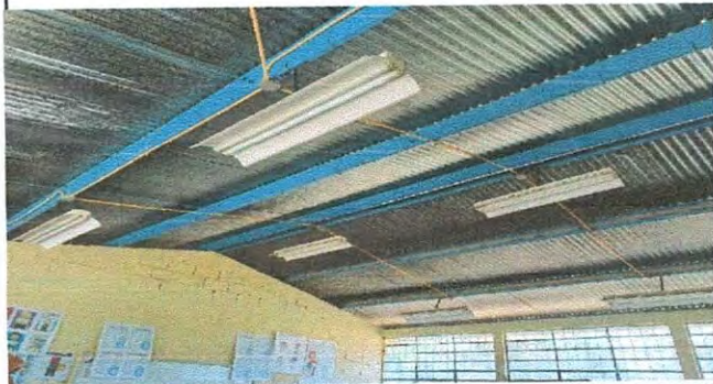
Foto 4: Reparación del sistema eléctrico
