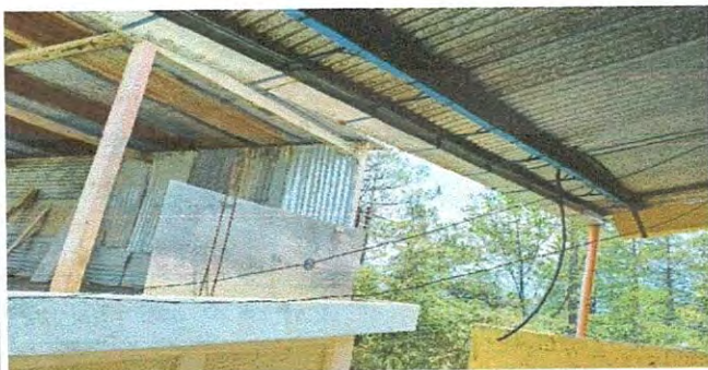
Foto 3: Reparación del sistema eléctrico
