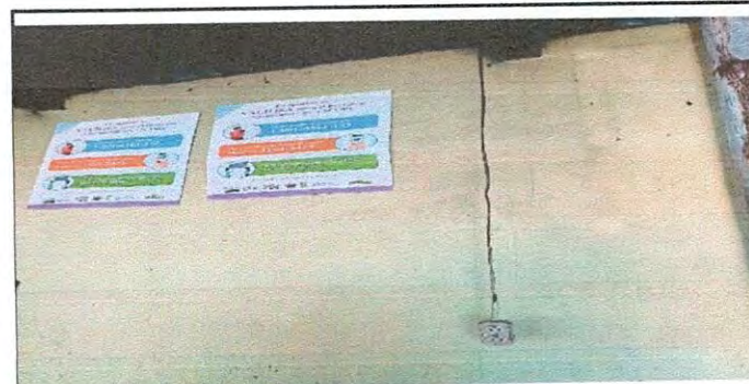
Foto 6: Reparación del sistema eléctrico
