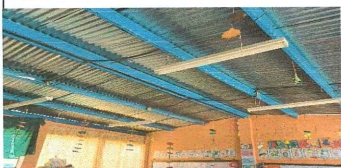
Foto7: Reparación del sistema electrico
