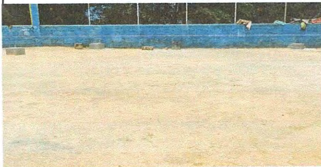
Foto 2: Losa de patio
