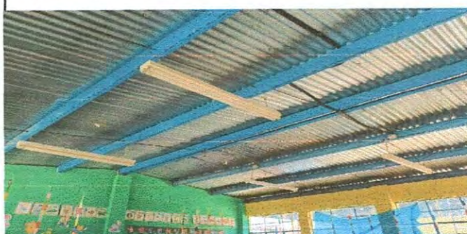
Foto 8: Reparación del sistema electrico
