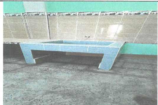
Foto 2: Suministro e instalación de lavatrastos de 0.80 m X 0.80 m y drenaje de pila. (modulo de cocina).
