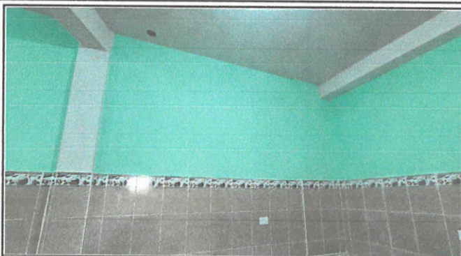
Foto 1, Suministro y aplicación de repello en muro (módulo de cocina).
