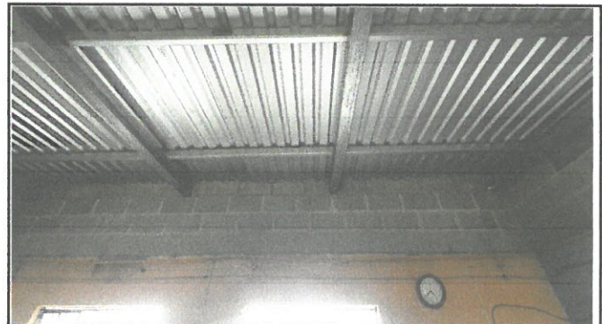
Foto 4 Suministro e instalación de estructura de metal galvanizado de portante de techo. (módulo de aula).
