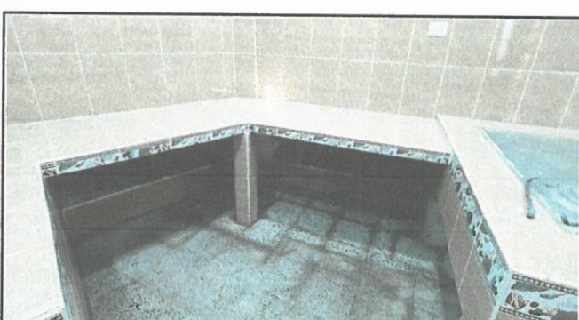
Foto 4: Suministro e instalación de mesa de concreto, de 0.70 X 10.10 m. (módulo de cocina).
