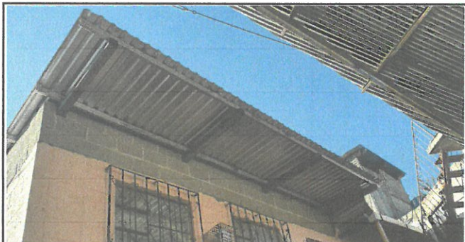
Foto 5 Suministro e instalación de lámina troqueda legitimo calibre 26.
