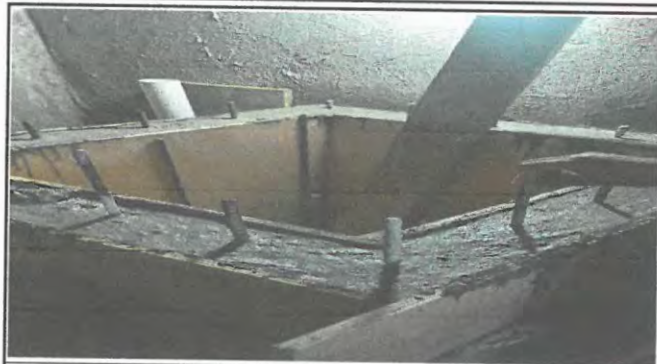
Foto 2: Suministro e instalación de lavatrastos de 0.80 m X 0.80 m y drenaje de pila. (modulo de cocina).
