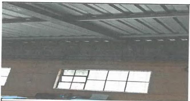
Foto 5 Suministro e instalación de lámina troqueada legítimo calibre 26.
