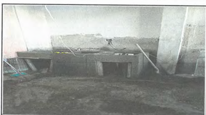
Foto 4: Suministro e instalación de pila de concreto de 0.85 X 1.95 m. (módulo de cocina).
