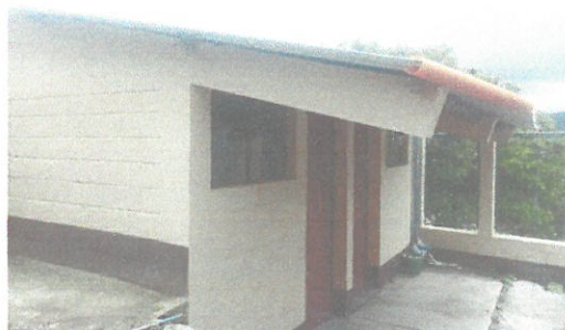
TECHO DE BAÑO
