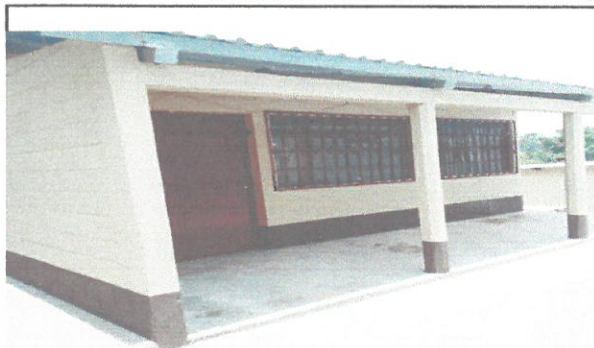
TECHO DE BUENA CONDICIÓN
