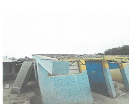
techo de baños
