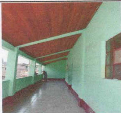
Foto 5: Corredor tercer nivel: Piso torta de cemento en mal estado. (Se sustituye por piso ceramico)
