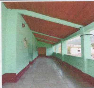
Foto 6: Corredor tercer nivel: Piso torta de cemento en mal estado. (Se sustituye por piso ceramico)
