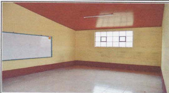
Foto 1: Aula 1: Piso torta de cemento en mal estado. (Se sustituye por piso ceramico)
