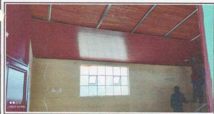
Foto 5: Aula 2: machimbre en mal estado y focos. (Se sustituye por cielo falso PVC y lámparas LED)
