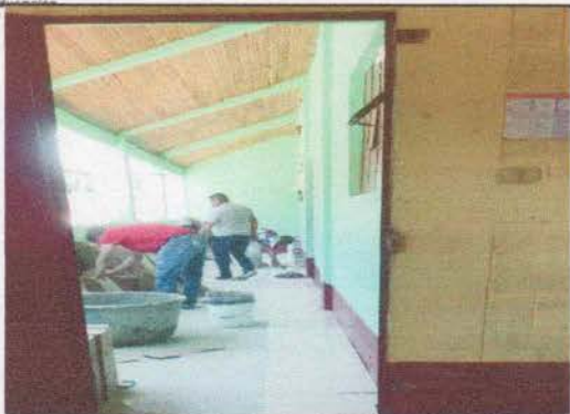
Foto 5: Corredor tercer nivel: Piso torta de cemento en mal estado. (Se sustituye por piso cerámico)
