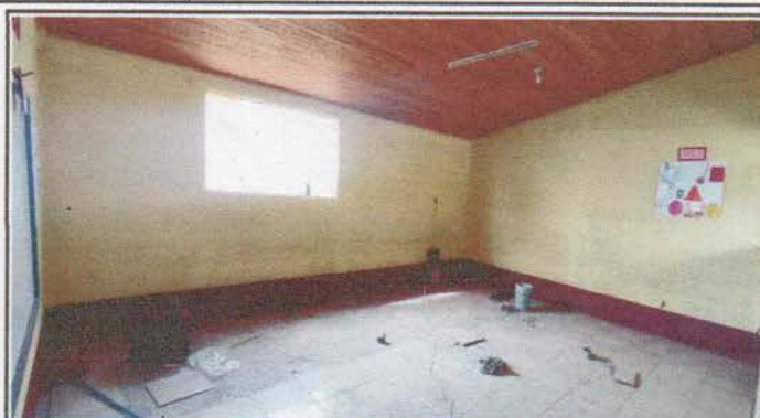
Foto 2: Aula 2: Piso torta de cemento en mal estado. (Se sustituye por piso ceramico)
