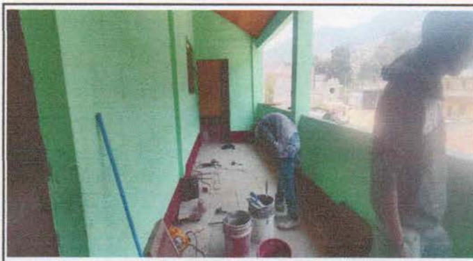
Foto 6: Corredor tercer nivel: Piso torta de cemento en mal estado. (Se sustituye por piso cerámico)
