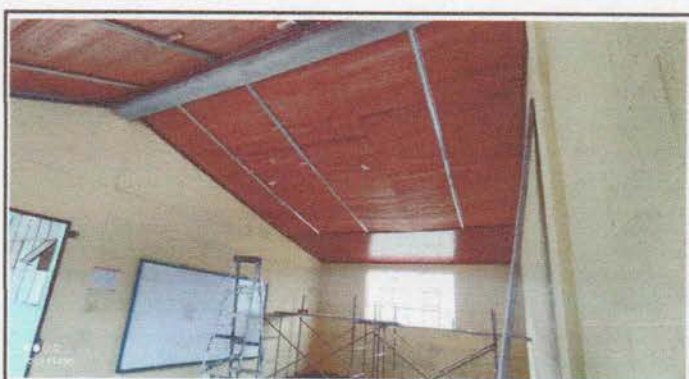
Foto 4: Aula 1: machimbre en mal estado y focos LED. (Se sustituye por cielo falso PVC y lámparas LED)
