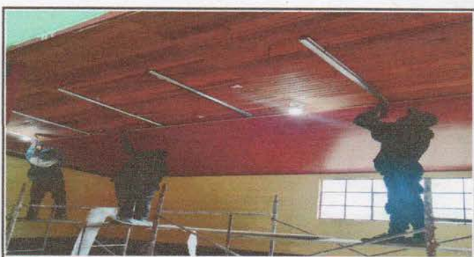
Foto 6: Aula 3: machimbre en mal estado y focos. (Se sustituye por cielo falso PVC y lámparas LED)
