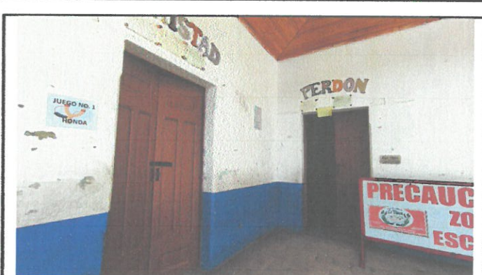
Foto 4: Restauración, tratamiento, accesorios y barnizado con poliuretano para exterior de puertas, por daños en ambos largueros, marcos de puerta, pestaña inferior, por daños estructurales por polilla y suministro de accesorios.
