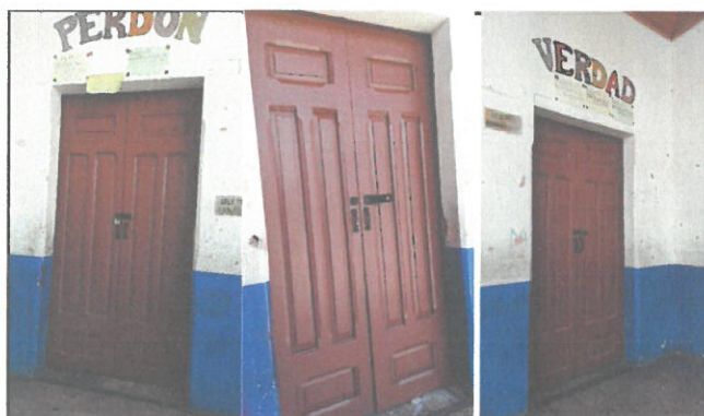
Foto 3: Restauración, tratamiento, accesorios y barnizado con poliuretano para exterior de puertas, por daños en ambos largueros con varios orificios ocasionados por el cambio constante de pasadores, alabadas y por polilla.
