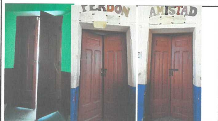
Foto 3: Restauración, tratamiento, accesorios y barnizado con poliuretano para exterior de puertas, por daños en ambos largueros con varios orificios ocasionados por el cambio constante de pasadores, alabadas y por polilla.
