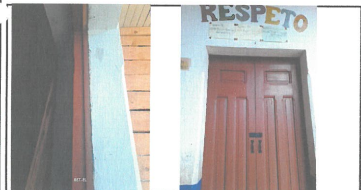
Foto 5: Restauración, tratamiento, accesorios y barnizado con poliuretano para exterior de puerta principal por daños estructurales por la exposición exterior, tamaño, deterioro en bisagras y descuadre total.
