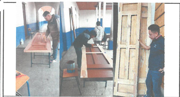
Foto 5: Restauración, tratamiento, accesorios y barnizado con poliuretano para exterior de puerta principal por daños estructurales por la exposición exterior, tamaño, deterioro en bisagras y descuadre total.
