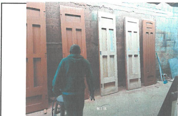
Foto 3: Restauración, tratamiento, accesorios y barnizado con poliuretano para exterior de puertas, por daños en ambos largueros con varios orificios ocasionados por el cambio constante de pasadores, alabadas y por polilla.
