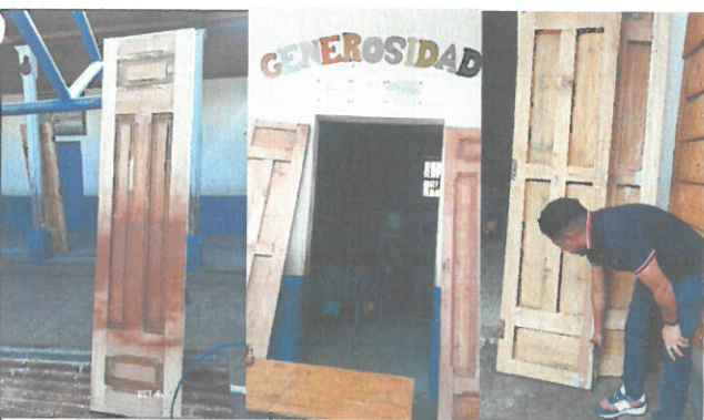
Foto 5: Restauración, tratamiento, accesorios y barnizado con poliuretano para exterior de puerta principal por daños estructurales por la exposición exterior, tamaño, deterioro en bisagras y descuadre total.
