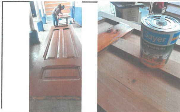
Foto 1: Restauración, tratamiento, accesorios y barnizado con poliuretano para exterior de puertas, por daños en ambos largueros con varios orificios ocasionados por el cambio constante de pasadores, alabadas y por polilla.
