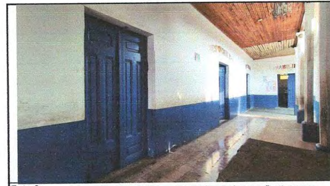
Foto 6: Restauración, tratamiento, accesorios y barnizado con poliuretano para exterior de puertas, por daños en ambos largueros con varios orificios ocasionados por el cambio constante de pasadores, alabadas y por polilla.
