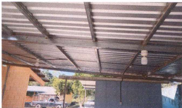
Foto 7: Suministro de lámina troquelada Aluzinc.
