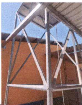
Foto 11: Suministro de torre de estructura metálica para instalación de deposito elevado.
