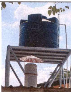
Foto 10: Suministro de deposito de agua de 1700 lts.
