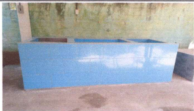
Foto 1: Suministro de pila de concreto, revestida de azulejos de dos lavaderos.
