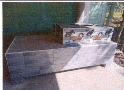
Foto 4: Suministro de estufa rural completa incluye chimenea y plancha de metal de tres hornillas.
