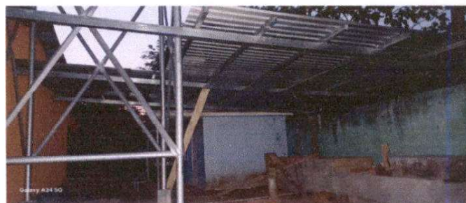
Foto 6: Suministro de estructura de metal.
