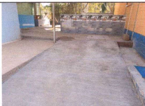
Foto 5: Suministro de piso de torta de concreto.
