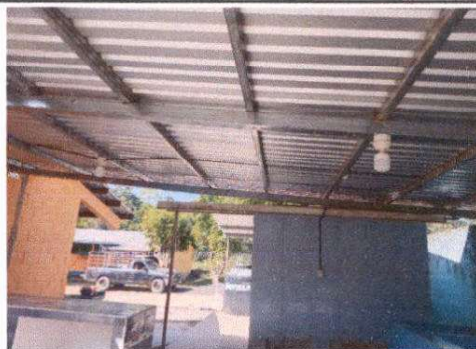
Foto 12: Suministro de sistema eléctrico.
