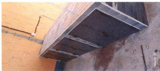
Foto 3: Suministro de puerta de metal para gabinete.
