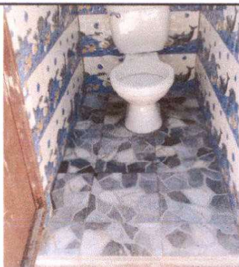
Foto 9: Suministro e instalación de piso cerámico antideslizante.
