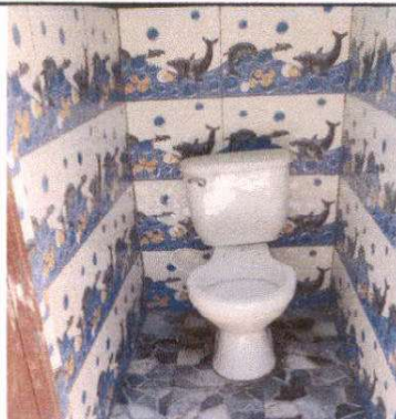
Foto 8: Suministro e instalación de azulejo en muros de servicios sanitarios.
