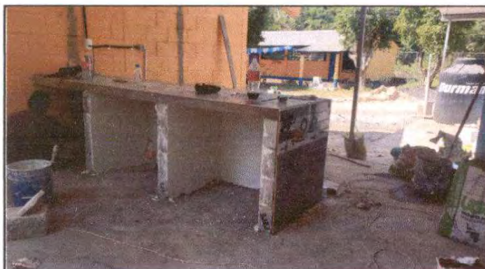
Foto 3: Suministro de puerta de metal para gabinete.
