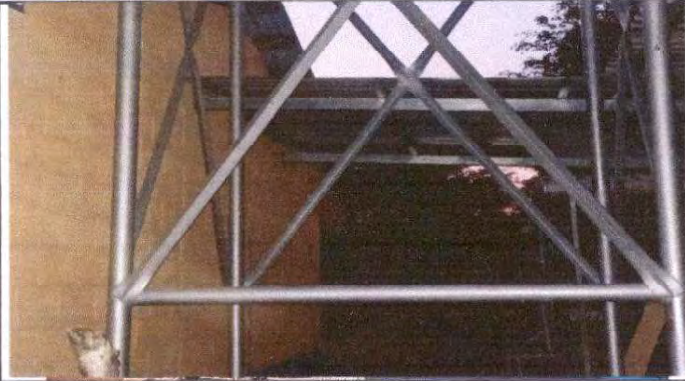
Foto 7: Suministro de lámina troquelada Aluzinc.
