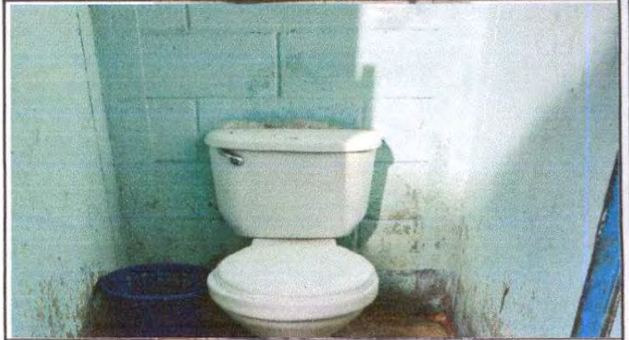
Foto 8: Suministro e instalación de azulejo en muros de servicios sanitarios.
