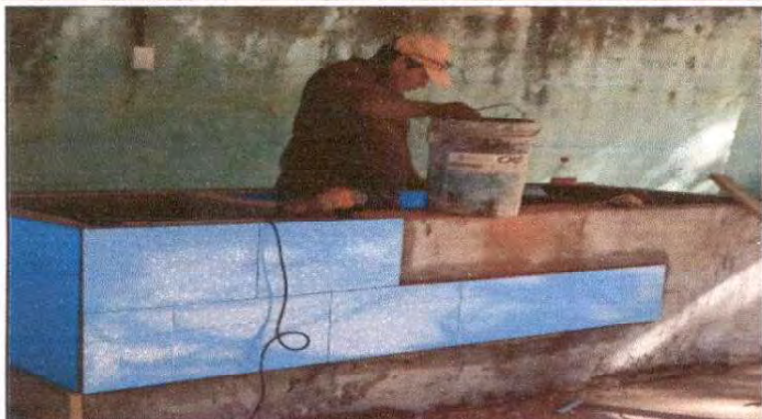
Foto 1: Suministro de pila de concreto, revestida de azulejos de dos lavaderos.
