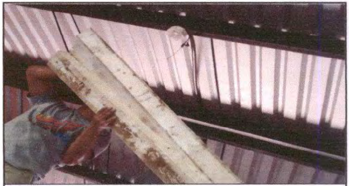
Foto 12: Suministro de sistema eléctrico.
