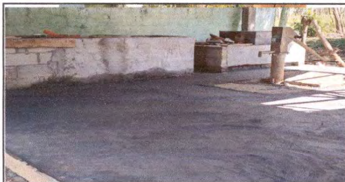
Foto 5: Suministro de piso de torta de concreto.
