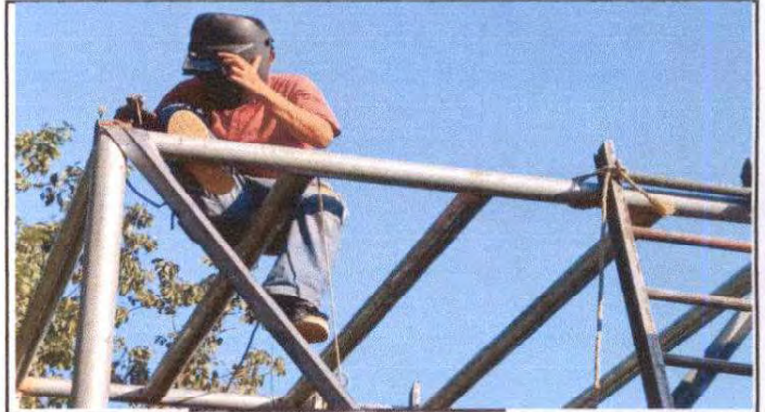
Foto 10: Suministro de deposito de agua de 1700 lts.
