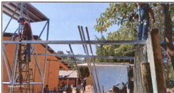
Foto 6: Suministro de estructura de metal.
