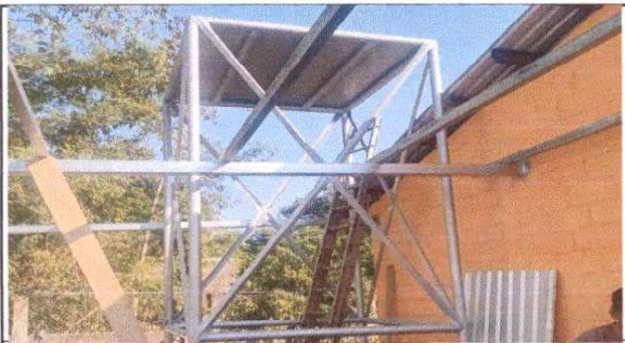
Foto 11: Suministro de torre de estructura metálica para instalación de deposito elevado.
