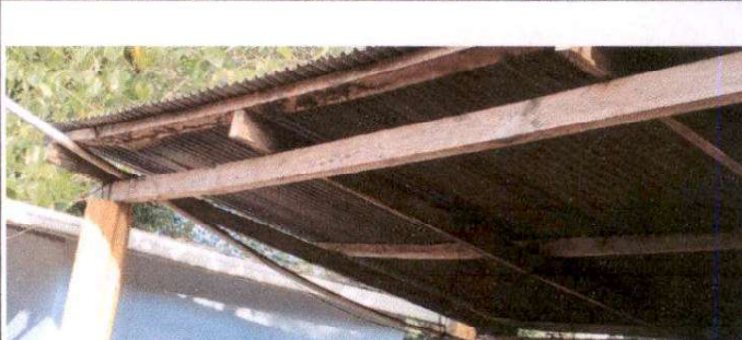
Foto 6: Suministro de estructura de metal.
