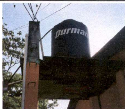
Foto 10: Suministro de deposito de agua de 1700 lts.
