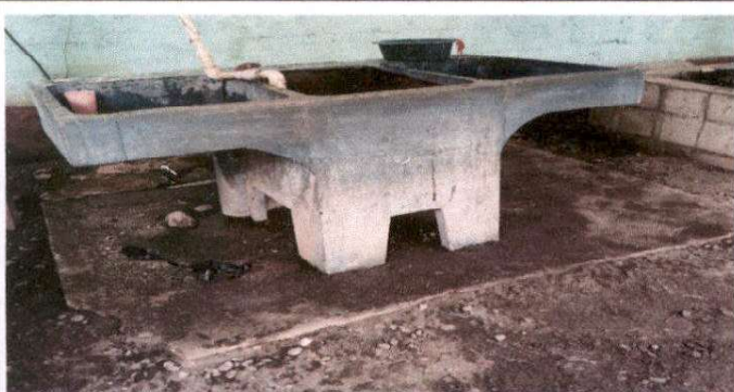
Foto 1: Suministro de pila de concreto, revestida de azulejos de dos lavaderos.
