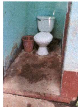
Foto 8: Suministro e instalación de azulejo en muros de servicios sanitarios.
