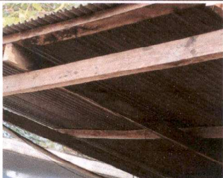
Foto 7: Suministro de lámina troquelada Aluzinc.
