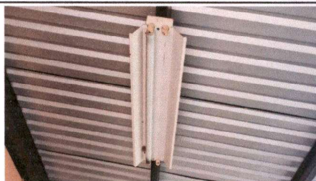
Foto 12: Suministro de sistema electrico.
