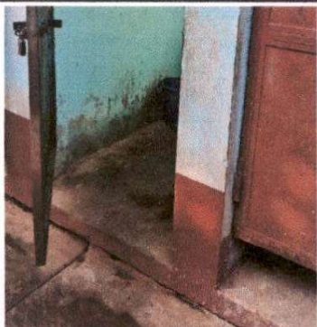
Foto 9: Suministro e instalación de piso cerámico antideslizante.
