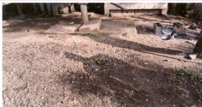
Foto 5: Suministro de piso de torta de concreto.
