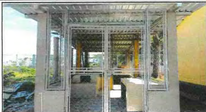
Foto 1: Mejoramiento de Cocina, Construcción de Estufa Rural
