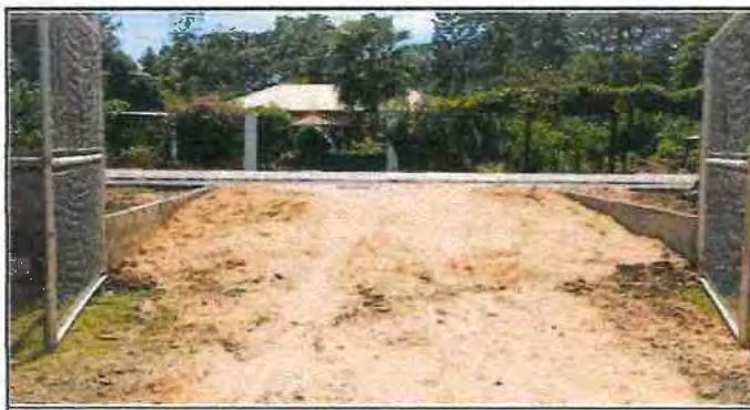
Foto 5: Sustitucion de Cuneta de Concreto
