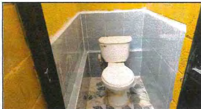
Foto 3: Instalación de azulejo en módulo de baños
