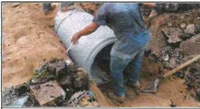
Foto 5: Sustitucion de Cuneta de Concreto
