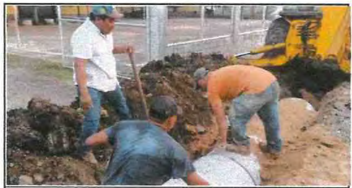
Foto 6: Relleno y Sustitucion de Cuneta de Concreto
