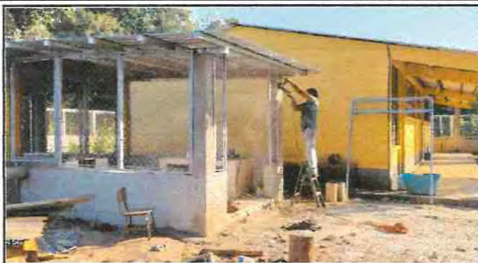
Foto 1: Mejoramiento de Cocina, Construcción de Estufa Rural
