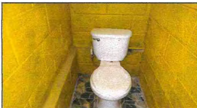
Foto 3: Instalación de azulejo en módulo de baños
