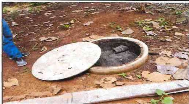
FOTO 1: SUSTITUCIÓN DE POZO DE ABSORCIÓN CON TBO DE CONCRETO DE 90CM X 300CM DE PROFUNDIDAD
