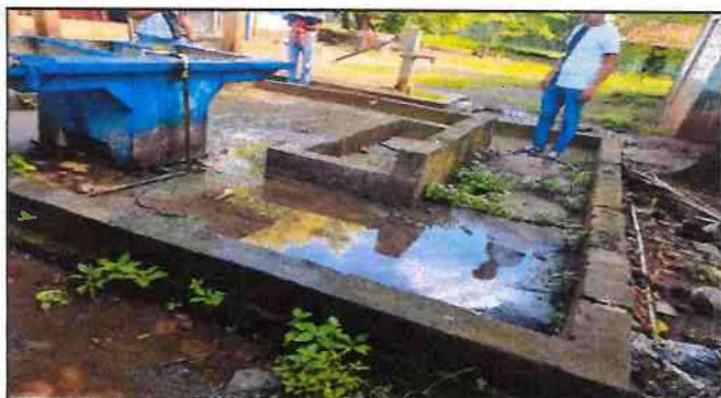
Foto 3: SUSTITUCIÓN DE POZO DE ABSORCIÓN CON TUBO DE CONCRETO DE 90CM X 300CM DE PROFUNDIDAD
