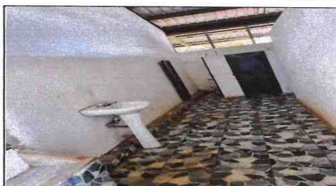
Foto 4: SUSTITUCIÓN DE AZULEJO EN LOS BAÑOS
