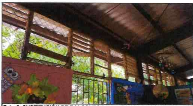
Foto 5: SUSTITUCIÓN DE BALCONES DE METAL POR METAL CON MEDIDAS 3.90CM DE ANCHO 0.85 DE ALTO PARA AULAS. 2.50CM DE ANCHO 0.85CM DE ALTO PARA AULAS
