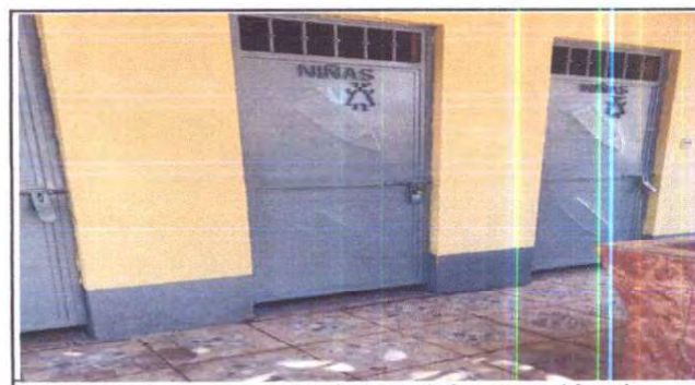
Foto 6: Pinturas en muros de interiores y exteriores en el área de cocina y servicio sanitario
