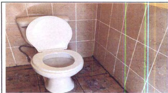
Foto 4: Colocacion de azulejos para los servicios sanitarios.
