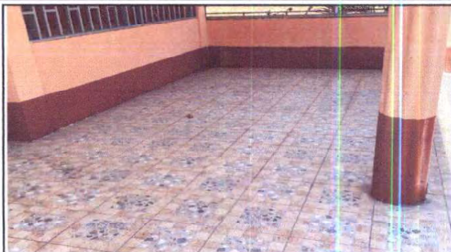
Foto 2: Colocación de piso cerámico antideslizante para la cocina y servicios sanitarios.
