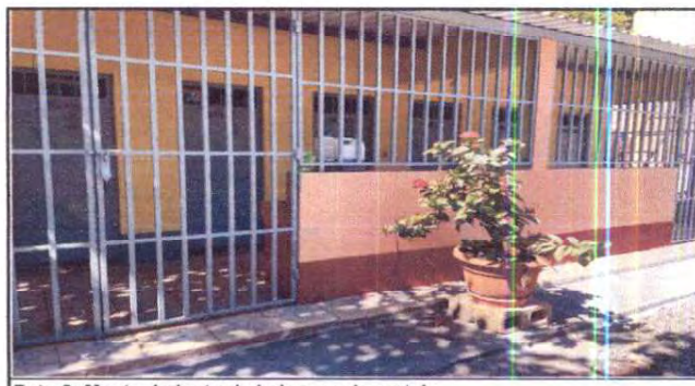
Foto 6: Mantenimiento de balcones de metal.
