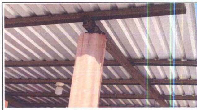
Foto 4: Colocación de lámina troquelada alizinc calibre 26 en el área de cocina
