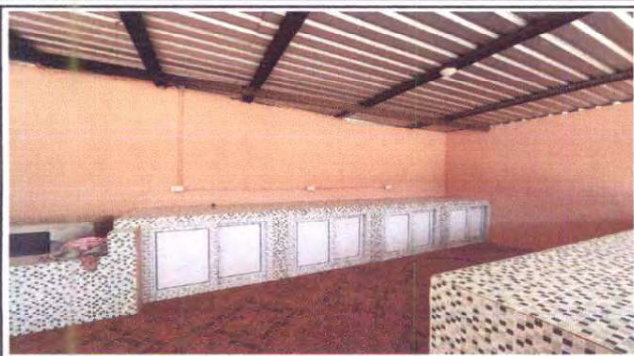
Foto1: Pintura en muros interiores y exteriores para el área de cocina y servicios sanitarios.
