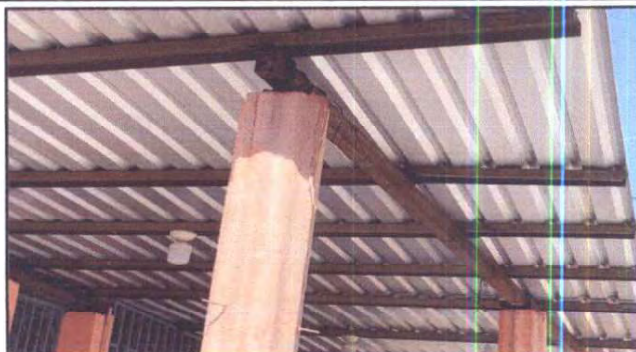
Foto 2: Colocación del sistema eléctrico para el área de cocina.
