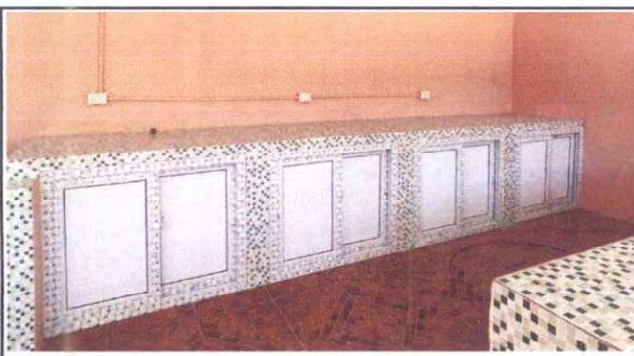
Foto 3: Colocación de azulejos para gabinetes de la cocina
