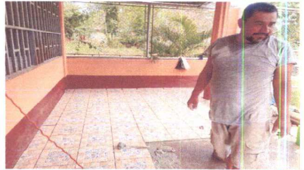
Foto 2: Colocacion de piso ceramico
