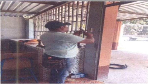
Foto1: Colocación de sistema eléctrico en el área de cocina
