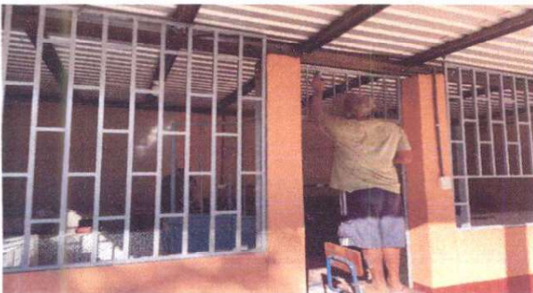
Foto 3: Mantenimiento de balcones de metal
