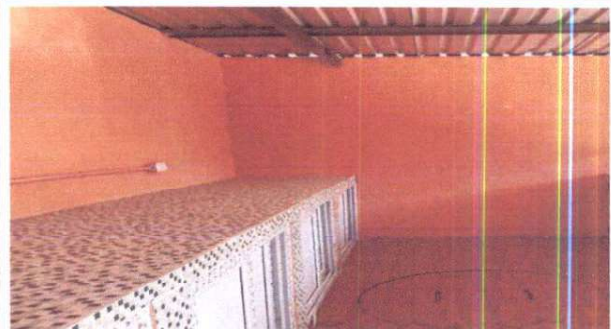
Foto 4 Colocación de azulejos para gabinete de cocina
