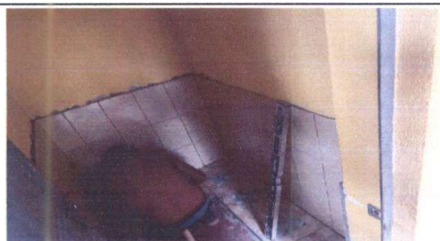
Foto 5: Colocación de azulejo en servicios sanitarios
