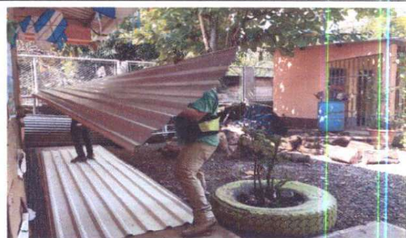
Foto 4: Recepción de lámina calibre 26 para la cocina
