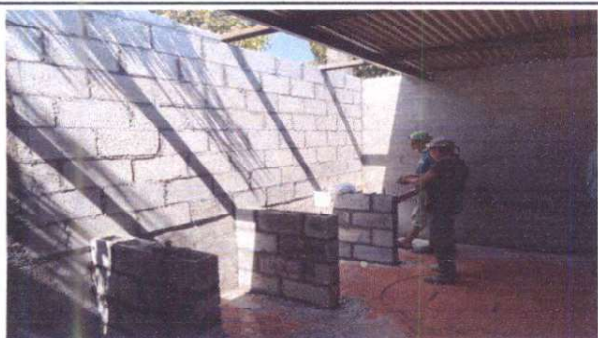
Foto1: construcción de gabinete
