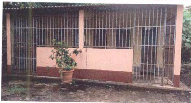
Foto 13: Mantenimiento de balcones de metal.
