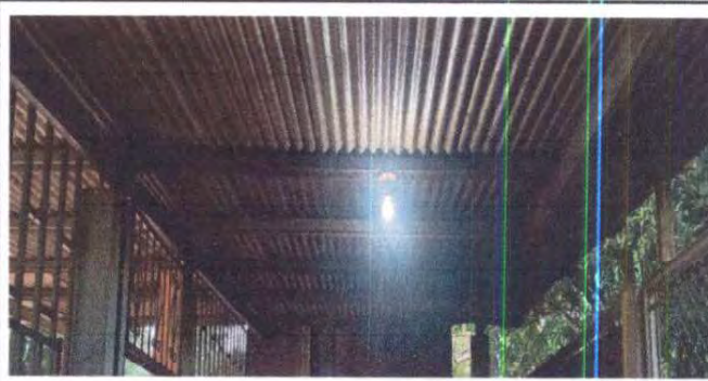
Foto 4: Sustitucion de lamina, por lamina troquelada aluzinc calibre 26 en area de cocina
