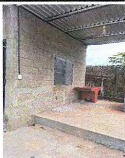
FOTO 11: SUMNISITRO DE LOSA DE CONCRETO
