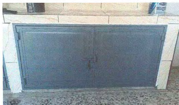
FOTO 6: SUMINISTRO DE PUERTA DE METAL PARA GABINETE
