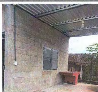
FOTO 14: SUSTITUCION DE ESTRUCTURA DE SOPORTE DE METAL POR METAL PARA EL AREA DE COCINA Y PILA 18 METROS
