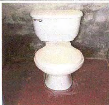
FOTO 15: SUSTITUCION DE INODORO
