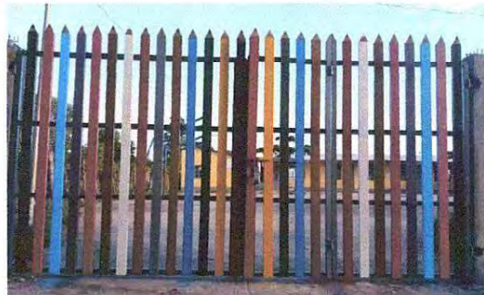
FOTO 20: MANTENIMIENTO A PORTON DEL METAL 4 X 2.25 METROS
