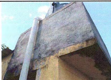
FOTO 18: SUMINISTRO DE TORRE DE CONCRETO PARA DEPOSITO DE AGUA DE 3 METROS DE ALTURA
