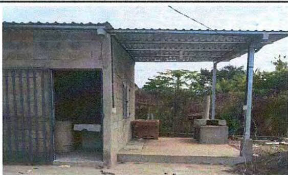
FOTO 13: SUSTITUCION DE LAMINA, POR LAMINA TROQUELADA ALUZINC CALIBRE 26 PARA AREA DE COCINA Y PILA 9 METROS
