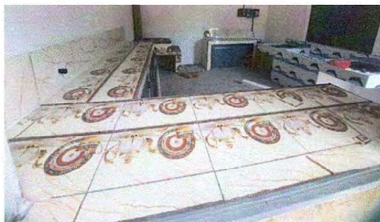
FOTO 9: SUMINISTRO DE AZULEJO PARA GABINETE DE COCINA
