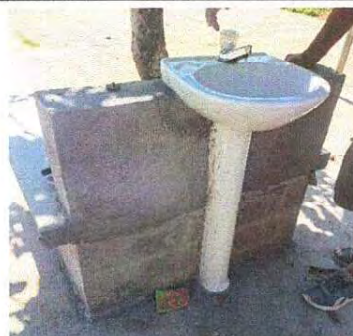
FOTO 16: SUSTITUCION DE LAVAMANOS
