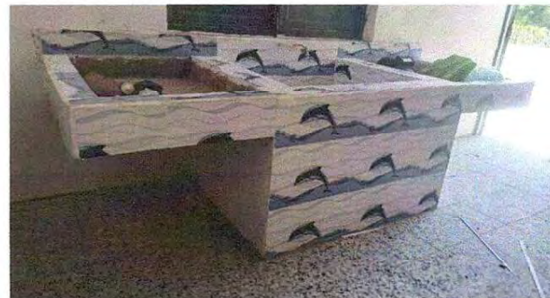
FOTO 10: SUMINISTRO DE PILA DE DOS LAVADEROS REVESTIDA DE AZULEJO (INCLUYE DRENAJE SANITARIO)
