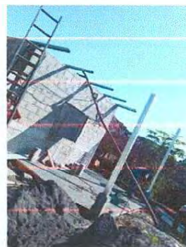
FOTO 14: SUSTITUCION DE ESTRUCTURA DE SOPORTE DE METAL POR METAL PARA EL AREA DE COCINA Y PILA 18 METROS
