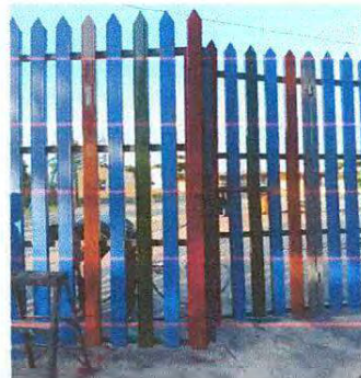
FOTO 20: MANTENIMIENTO A PORTON DEL METAL 4 X 2.25 METROS
