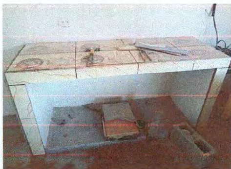
FOTO 9: SUMINISTRO DE AZULEJO PARA GABINETE DE COCINA
