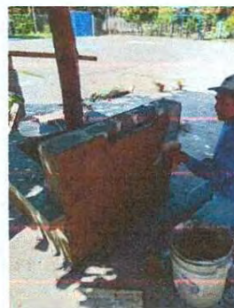
FOTO 16: SUSTITUCION DE LAVAMANOS
