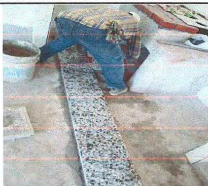
FOTO 1: SUSTITUCION DE PISO DE TORTA DE CONCRETO POR PISO DE GRANITO
