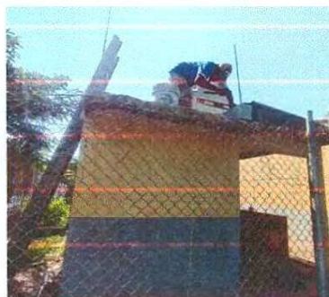
FOTO 18: SUMINISTRO DE TORRE DE CONCRETO PARA DEPOSITO DE AGUA DE 3 METROS DE ALTURA
