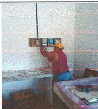
FOTO 5: SUSTITUCION DE SISTEMA ELECTRICO (INCLUYE CABLE, 4FOCO, 4 PLAFONES)
