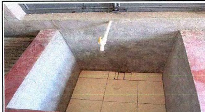
Foto 10: Suministro de Pila de 2 Lavaderos revistida de Azulejo (Incluye drenaje sanitario)
