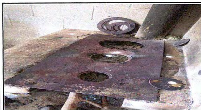
Foto 3: Sustitucion de Plancha de Metal de 3 hornias, incluye Chimenea.
