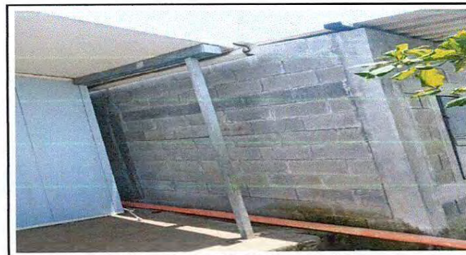
Foto 12: Suministro de Canal de Metal y bajada de Agua pluvial.
