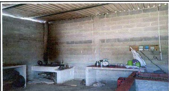
Foto 9: Suministro de Azulejo para gabinete de Cocina.
