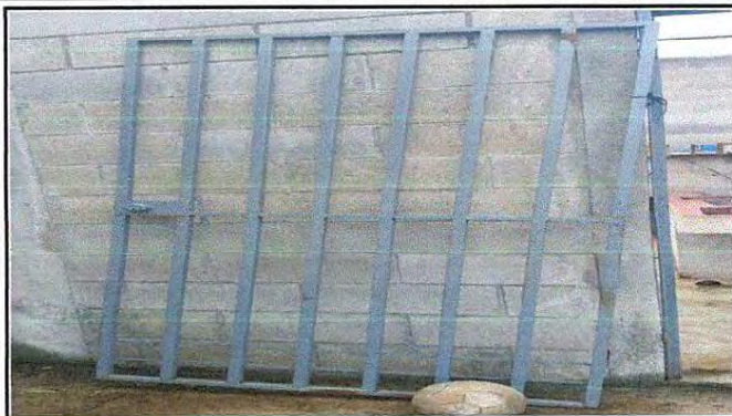
Foto 8: Mantenimiento de Puerta Reja de Metal.
