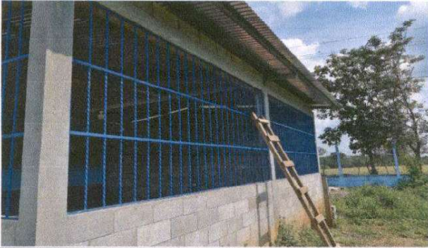
VENTANAS (SUMINISTRO DE BALCONES DE METAL PARA AULAS)
