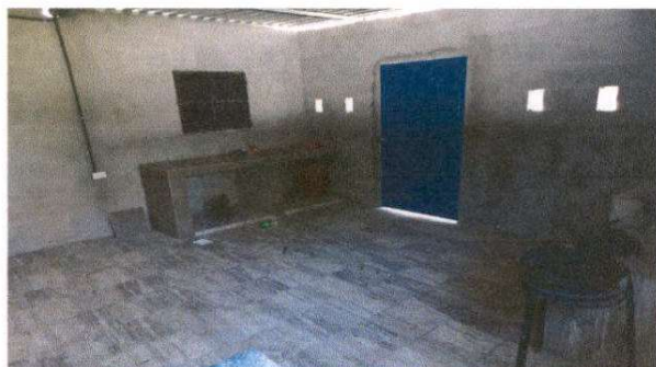
SUSTITUCIÓN DE PISO CONCRETO POR PISO CERÁMICO
