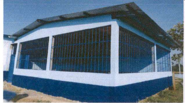
VENTANAS (SUMINISTRO DE BALCONES DE METAL PARA AULAS)
