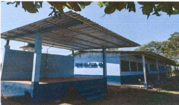
ESTRUCTURA DE TECHO (SUSTITUCIÓN DE ESTRUCTURA DE MADERA POR METAL PARA ESCENARIO)
