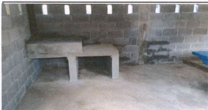
SUSTITUCIÓN DE PLANCHA DE METAL 3 HORNILLAS
