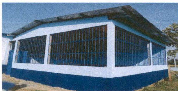
PINTURA EN MUROS EXTERIORES E INTERIORES
