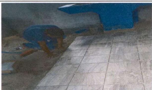
SUSTITUCIÓN DE PISO CONCRETO POR PISO CERÁMICO
