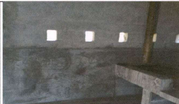
CERNIDO EN MURO INTERIOR
