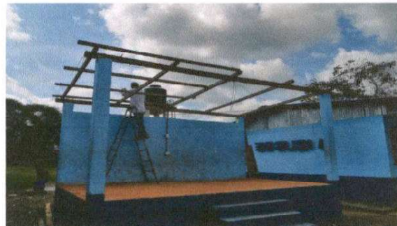
CUBIERTA DE LÁMINA (SUSTITUCIÓN DE LÁMINA POR LÁMINA TROQUELADA ALUZINC C/26 PARA EL ESCENARIO)
