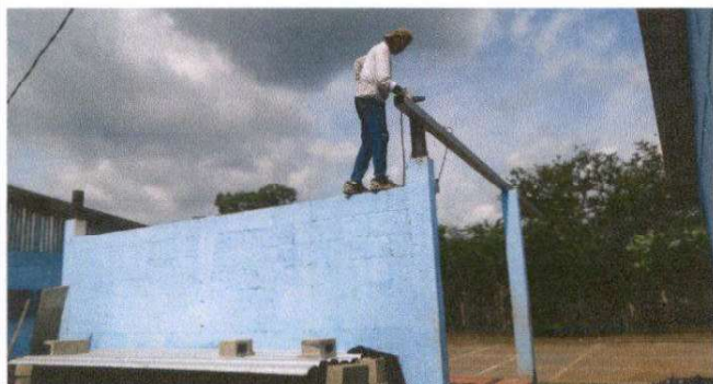
ESTRUCTURA DE TECHO (SUSTITUCIÓN DE ESTRUCTURA DE MADERA POR METAL PARA ESCENARIO)
