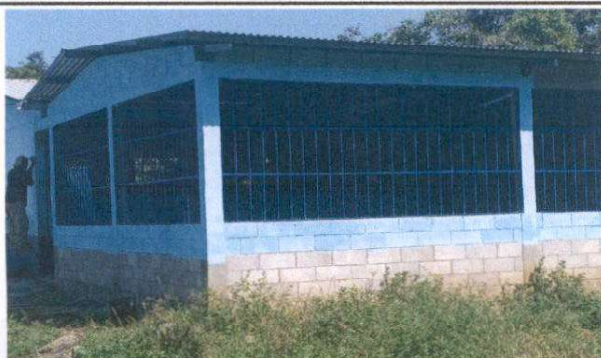
PINTURA EN MUROS EXTERIORES E INTERIORES
