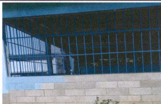
VENTANAS (SUMINISTRO DE BALCONES DE METAL PARA AULAS)
