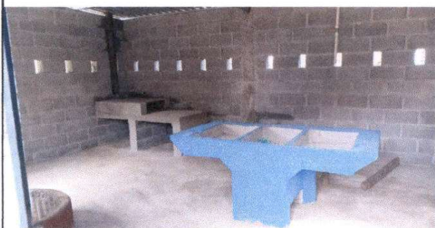
SUSTITUCION DE PISO CONCRETO POR PISO CERAMICO
