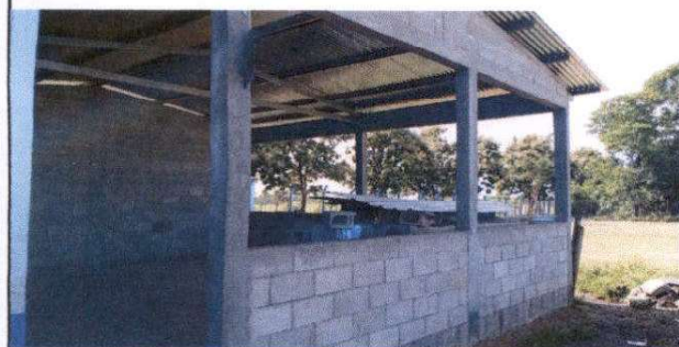
VENTANAS ( SUMINISTRO DE BALCONES DE METAL PARA AULAS)
