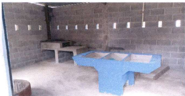
SUSTITUCION DE PLANCHA DE METAL DE 3 HORNILLAS
