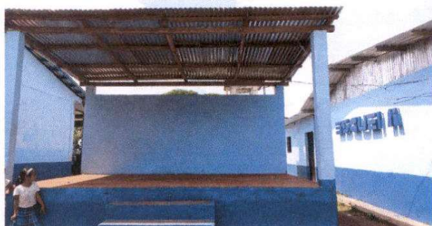
ESRTRUCTURA DE TECHO (SUSTITUCION DE ESTRUCTURA DE MADERA POR METAL PARA EL ESCENARIO)
