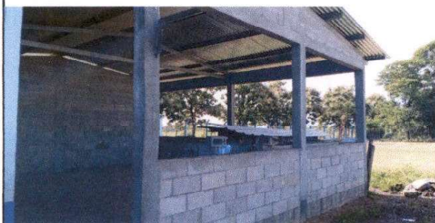
PINTURA EN MUROS EXTERIORES E INTERIORES
