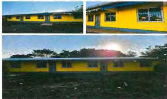
Pintura en muros interiores y exteriores.
