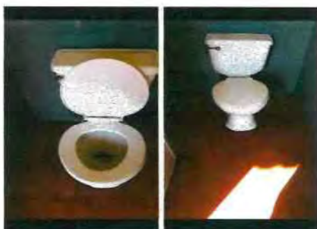
Servicios sanitarios / sustitución de inodoro y accesorios.
