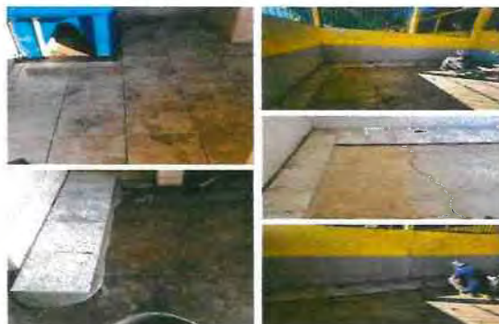
Piso / sustitución de torta de concreto por piso cerámico en cocina y aula.
