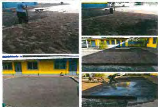
Losa de patio / sustitución de losa de patio de concreto.
