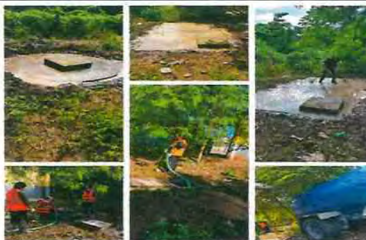
Limpieza de fosa séptica
