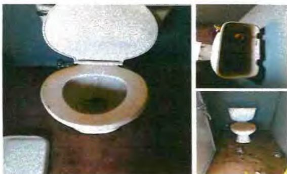
Servicios sanitarios / sustitución de inodoro y accesorios.
