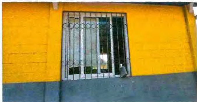
Pintura en muros interiores y exteriores.
