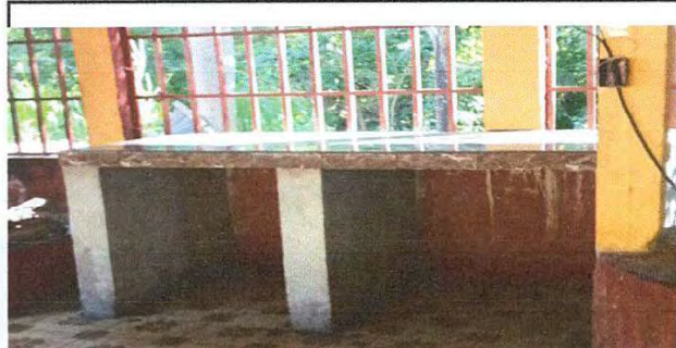
Foto 2: Plancha de concreto en cocina.
