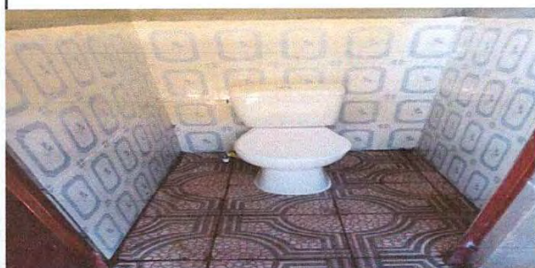
Foto 4: Sustitución de inodoros (incluye) sus accesorios.
