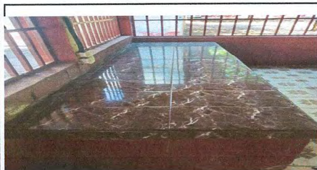
Foto 3: Reparación de azulejos en muebles de cocina.
