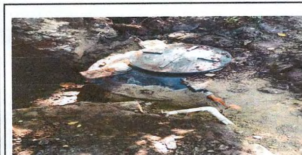
Foto 5: Sustitución de tubería PVC lineal principal de aguas negras
