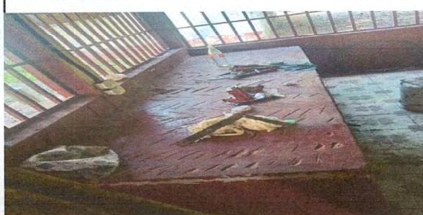
Foto 3: Reparación de azulejos en muebles de cocina.
