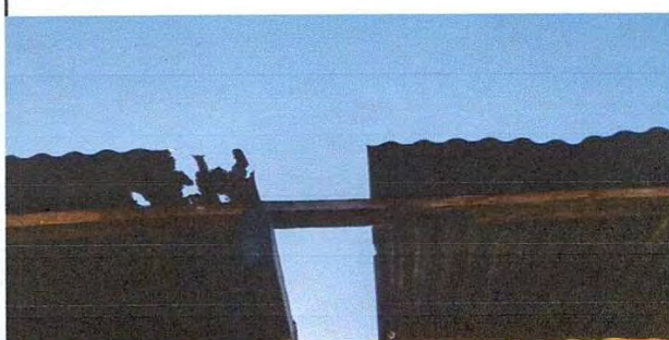
Foto 4: Sustitución de lámina. Por lámina troquelada aluzinc calibre 26
