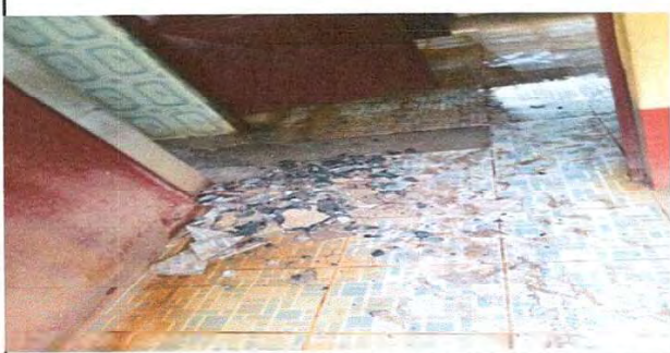
Foto 3: Sustitución de piso de granito, por piso cerámico antideslizante.
