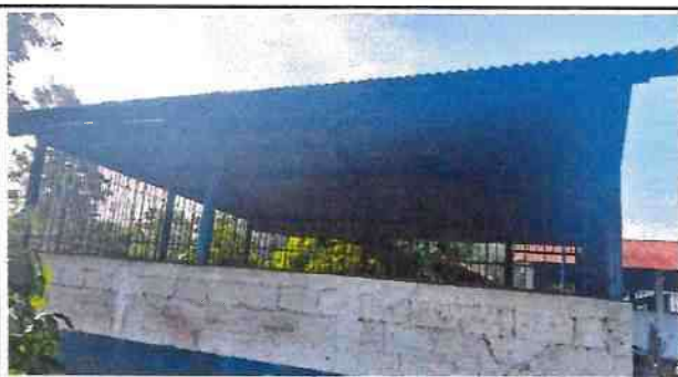
foto 3 Levantado de muro de Block en área de ventanas
