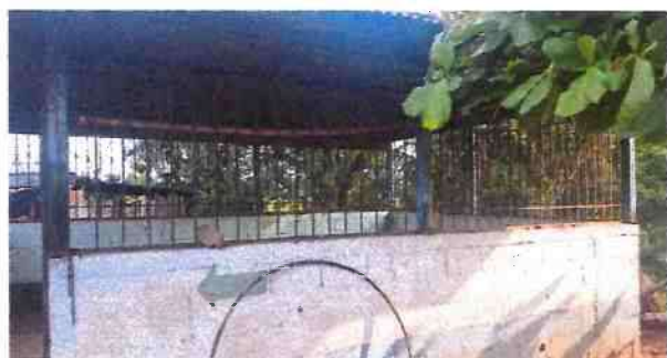
foto 1 Levantado de muro de block en área de ventanas
