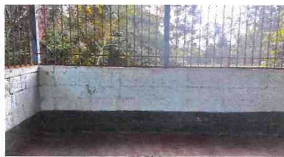
foto 4 Suministro de pila de cemento de dos lavaderos
