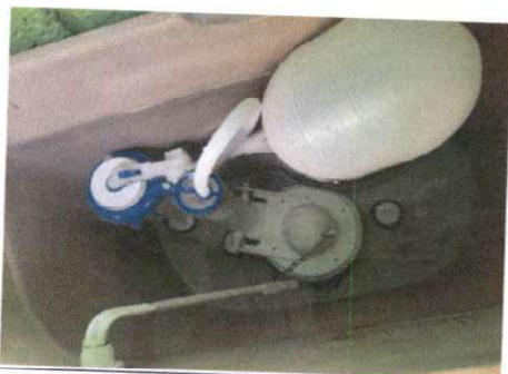
Foto 5: Sustitución de kit de sanitario
