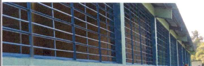
Foto 3: Mantenimiento de balcones.
