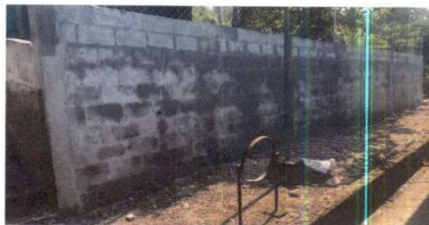
Foto 6: Repello de muro.
