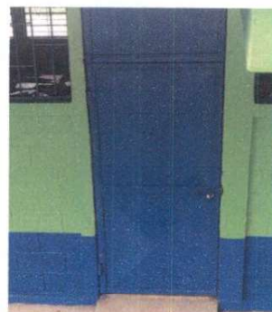
Foto 4: Mantenimiento de puertas.
