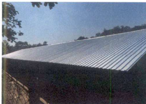
Foto1: Sustitución de lámina troquelada.
