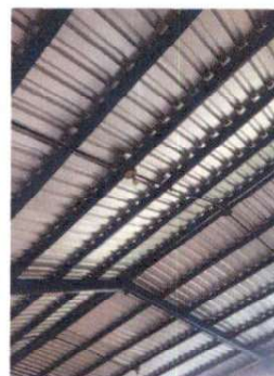
Foto 2: Mantenimiento de estructura de techo.
