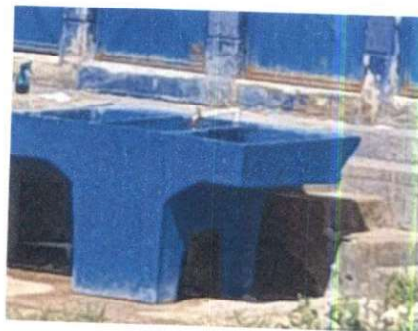
Foto 2: Instalación de pila.
