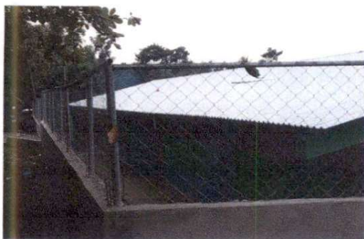
Foto 5: Sustitución de malla galvanizada.
