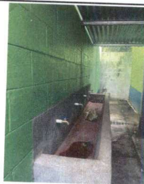
Foto 4: Reparación de estructura y techo de galera de lavamanos.
