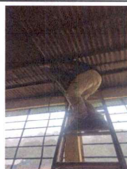
Foto 2: Mantenimiento de la estructura metálica.
