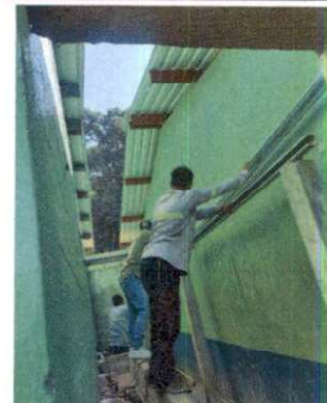
Foto 4: Instalación del techo de la galera de los lavamanos.
