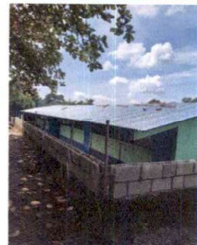
Foto 6: Preparación de pared a repellar.
