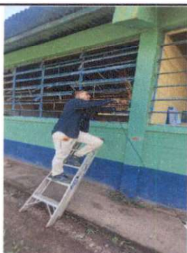
Foto 3: Mantenimiento de los balcones
