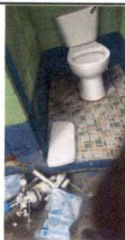
Foto 5: Colocación de kit de sanitario
