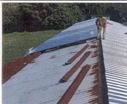
Foto1: Cambio de lámina
